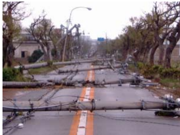
電柱の倒壊による道路閉塞
