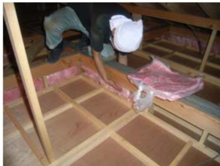
壁上端の気流止め
