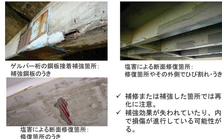
ゲルバー桁の鋼板接着補強箇所:
