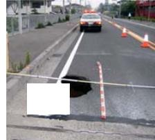
過去に橋台背面で路面陥没
