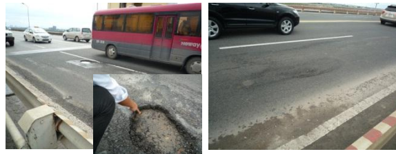
タンロン橋現地視察
