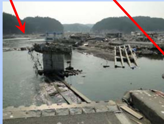
裏返しで落下した上部構造
