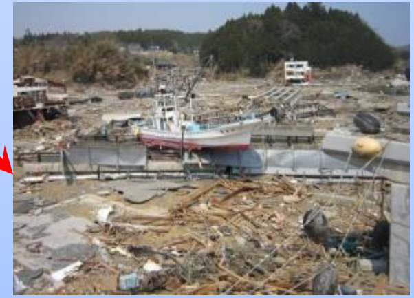
通信ケーブルが繋がったまま着地した連続でない隣接径間
