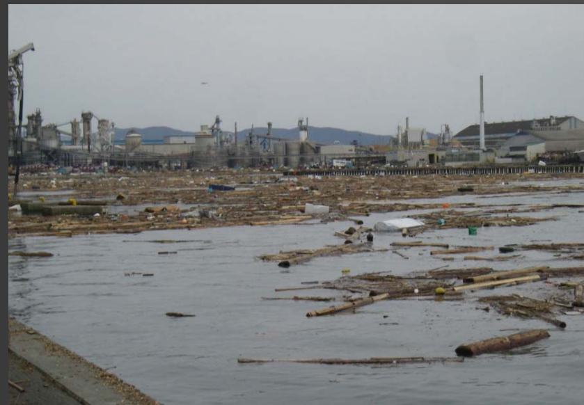
港内の浮遊物(石巻港)
