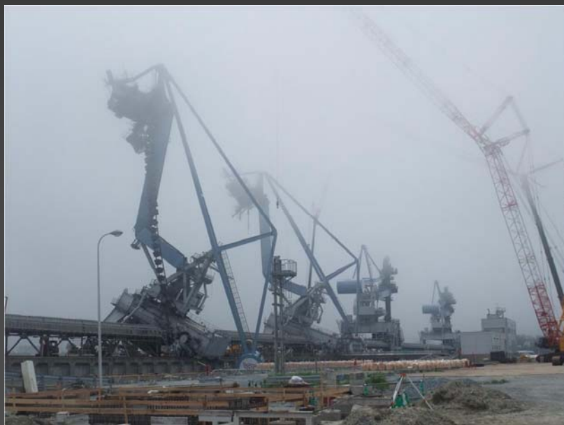
アンローダーの倒壊(相馬港)
