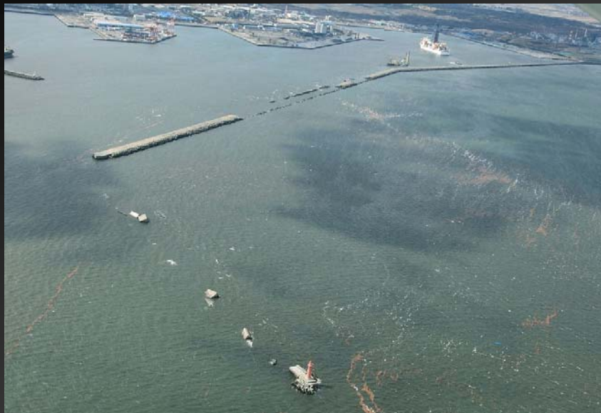
防波堤の倒壊(八戸港)
