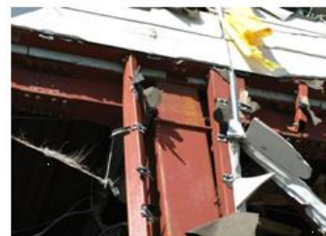
写真3 建物の柱梁部材
