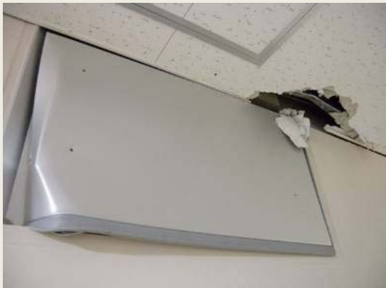
耐火カバーの損傷
