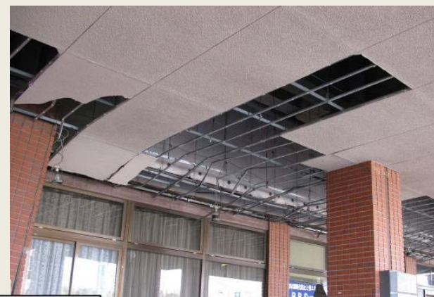
外壁パネルの落下
