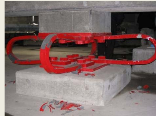
U字形ダンパーの 塗装の剥離
