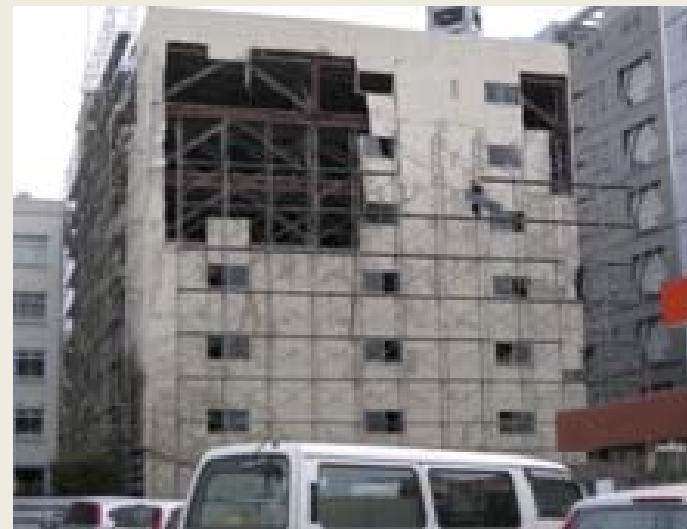
外壁パネルの落下
