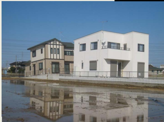
大規模な液状化と建築物等の沈下、傾斜
