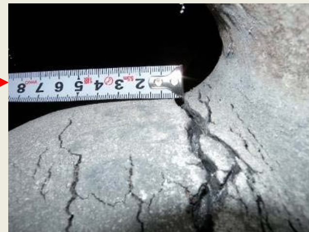
U字形ダンパーの 塗装の剥離
