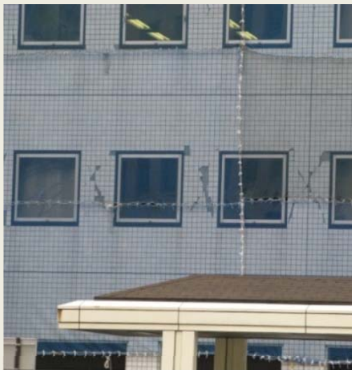
ひび割れとタイルの 剥落
