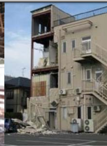
天井材の顕著な落下及び外装材の落下
