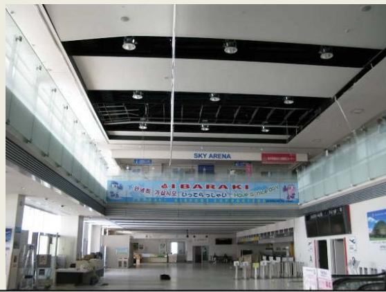
吊り天井の損傷、落下
