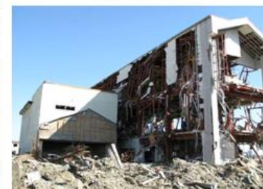
写真4 隣接するRC建物
