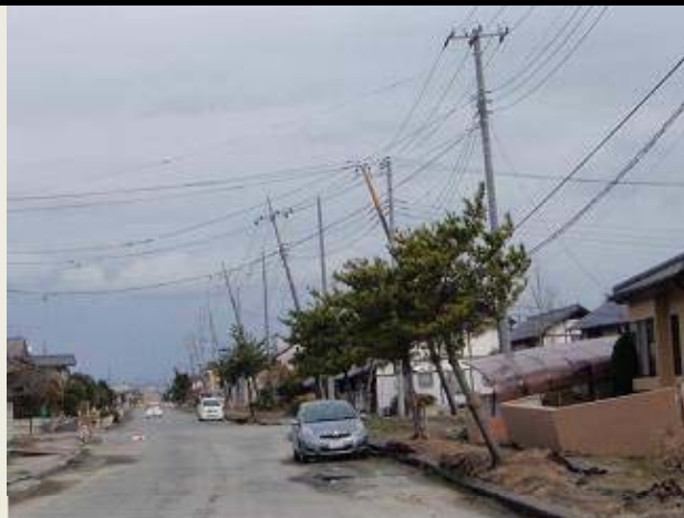
大規模な液状化と建築物等の沈下、傾斜
