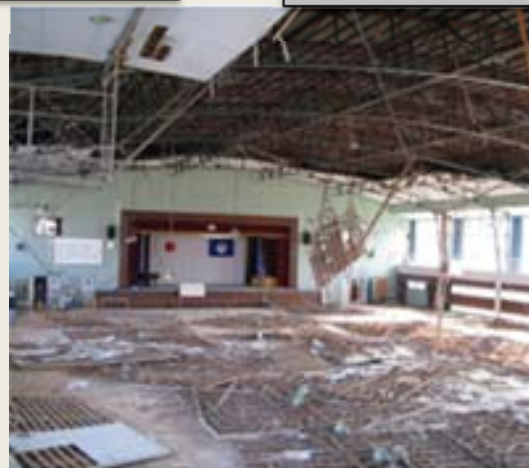
天井材の顕著な落下及び外装材の落下
