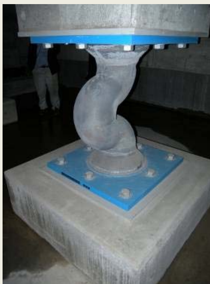
耐火カバーの損傷
