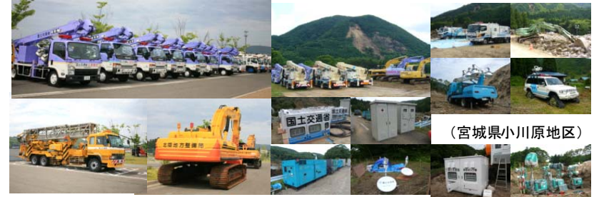
【岩手河川国道事務所】 (一関出張所)
