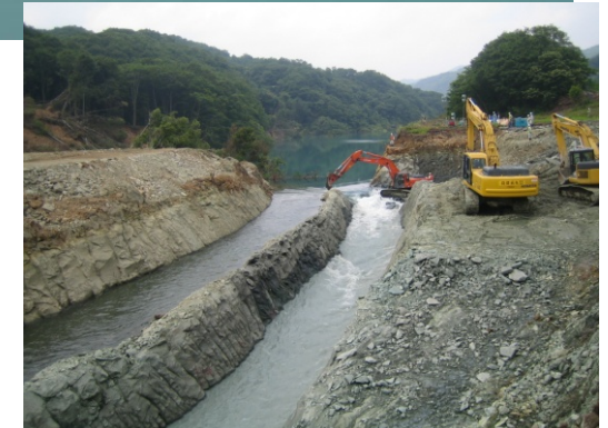
水路の拡幅工事完了 (7月5日)
