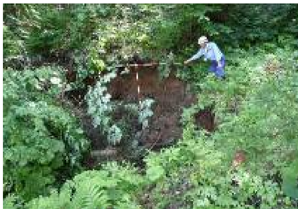
岩手県旧衣川村での点検状況
