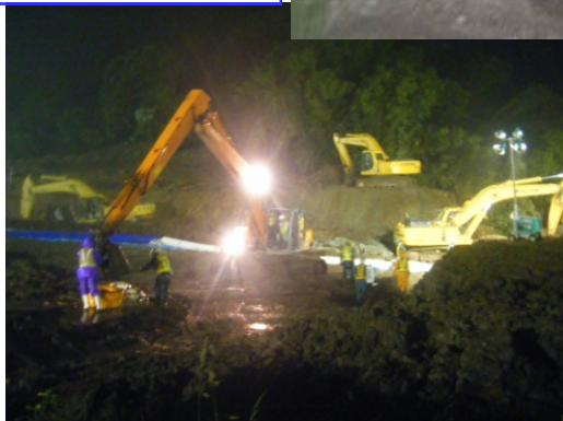
24時間態勢で仮排水路掘削工事を実施 (6月18日～26日)
