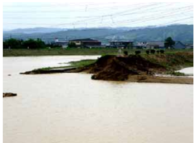
写真-1.1 五十嵐川三条市内の破堤状況
