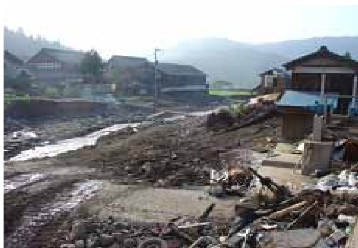
写真-2.7 土砂氾濫状況(福井市浄教寺)
