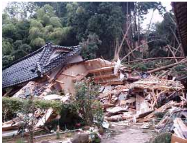
写真-1.5 出雲崎町大字中山で発生したのがけ崩れの様子
