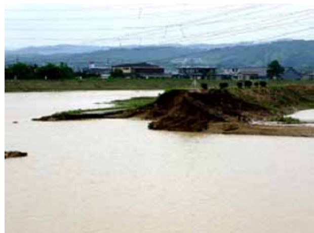
写真-1.1 五十嵐川三条市内の破堤状況
