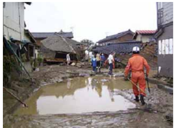
写真-1.4 中之島町内の家屋損壊状況
