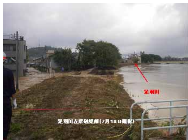
写真-2.1 破堤時状況
