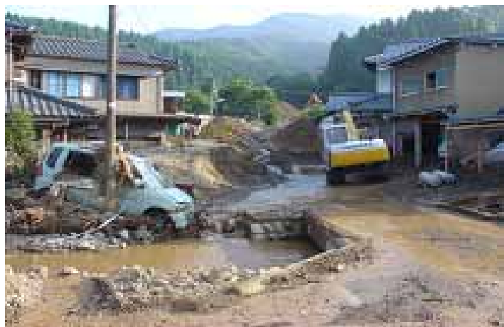
写真-2.5 土砂氾濫状況（美山町蔵作）
