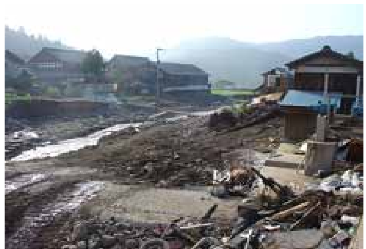
写真-2.7 土砂氾濫状況（福井市浄教寺）
