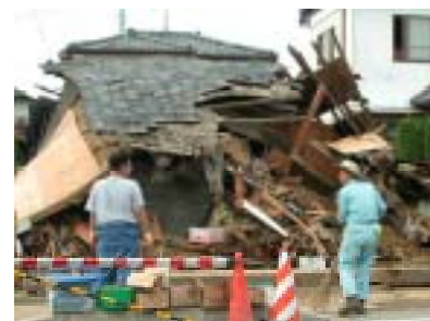
写真-8 店舗併用住宅被害例
