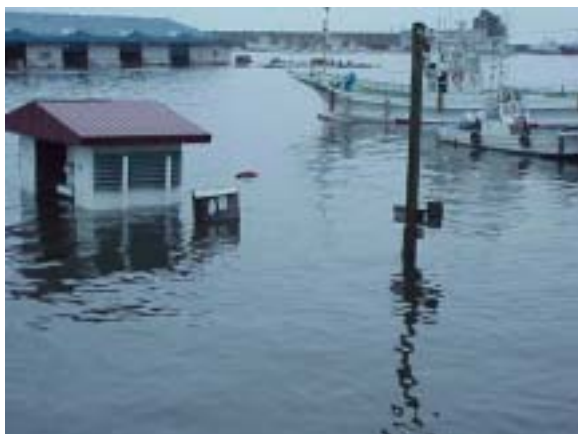
写真-13 津波により冠水した十勝港 (広尾海上保安署提供)
