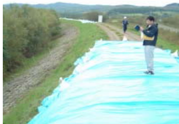
写真-3 パイルネット施工箇所 (シートで被われた区間が被災し、その間の対策区間は無被災)
