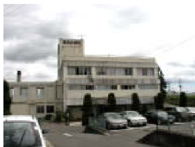
写真-6.1 南棟全景
