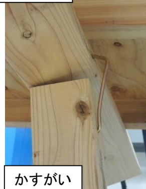
小屋組各部の接合方法ごとの損傷状況
