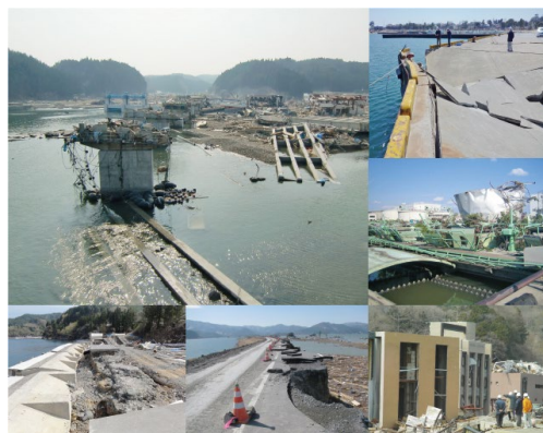
写真－1 被災状況調査した構造物・建築物
