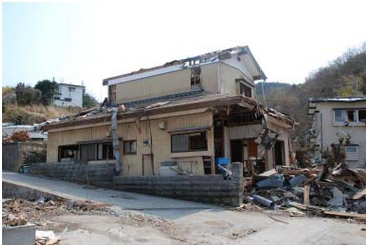
写真 4.3-7 2階上部まで浸水したと推察される住宅（女川町南側斜面）
