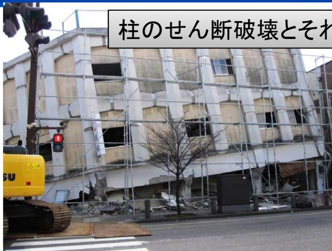
柱のせん断破壊とそれに伴う層崩壊
