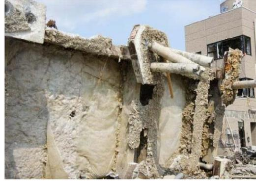
写真 4. 2-6 転倒した RC 造の基礎
