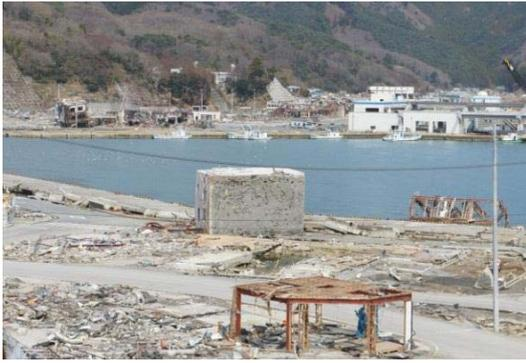
写真 4. 2-5 転倒した RC 造(手前は S 造)
