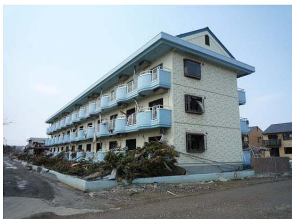
写真 4.4-2 共同住宅：RC 造 3 階建て；建物 2 階高さまで津波痕が認められる；3 階では、ガラスが残る；建物背面に木造住戸が残る。
