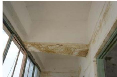
写真 4. 2-7 天井下 空気溜り
