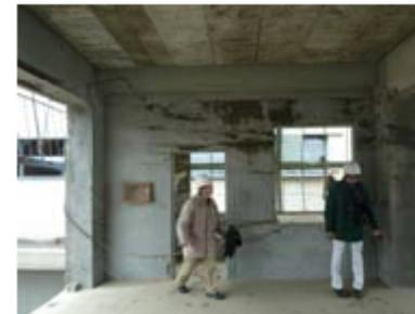
写真3 建物1階の浸水痕
