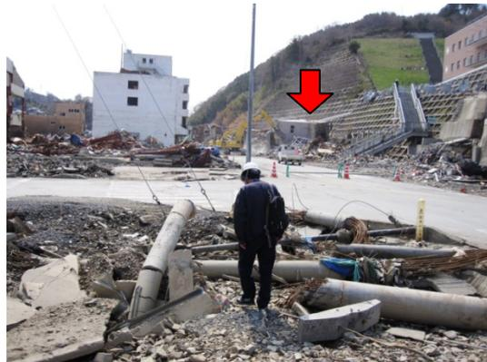
写真 3-13 手前の杭が抜け出している土地から
