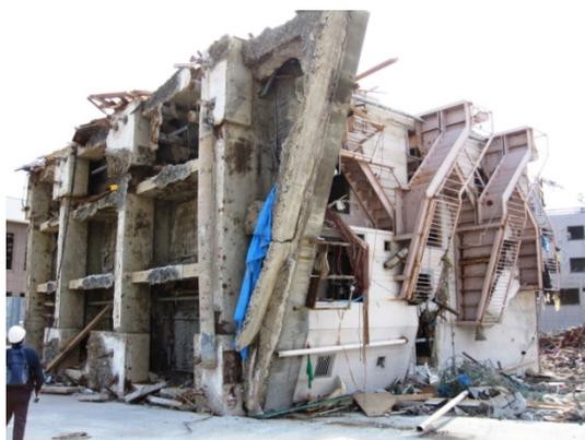
写真 3-15 3階建て鉄骨造建築物の転倒
