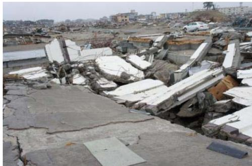
写真 4. 2-8 崩壊した RC 造(名取市)
