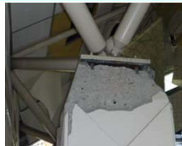
柱脚（支承部）コンクリート剥落
