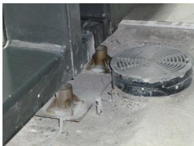
写真 3-35 大扉の中央留めピンの破壊 (撤去後)
