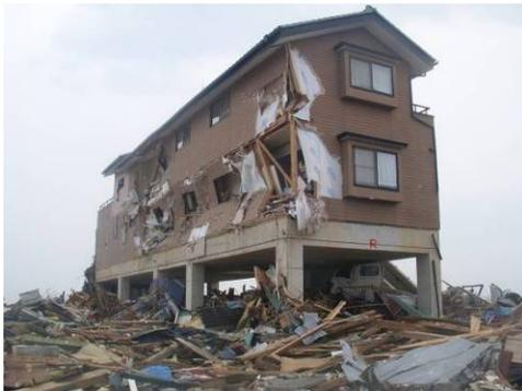
写真 3-46 1階部分が人工地盤の木造住家は流失を免れている。
