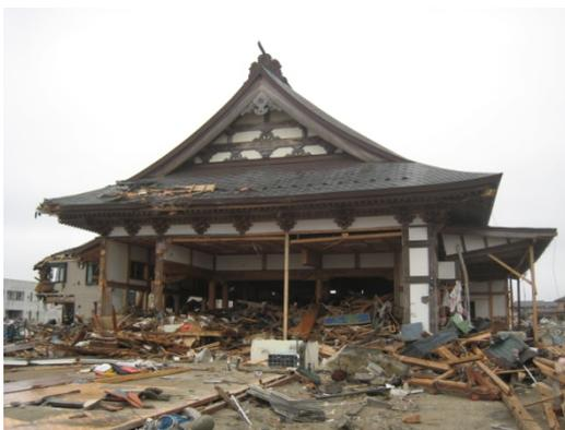
写真 3-47 この寺社は本堂の柱が折れていたが、倒壊しなかった。余震等で倒壊しないように、応急的な補強がなされていた。開口部が大きく、津波の流れ方向に平行に壁があったことが倒壊しなかった理由と考えられる。また、この本堂の蔭にあった住家の被害は軽微であった。
