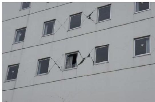
写真 4.2-20 非構造壁の被害
