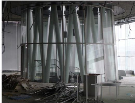
写真 3-26 円形鋼管を用いたシャフト（7階）
