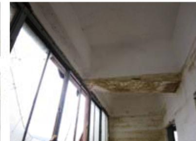
写真4 建物1階の浸水痕
