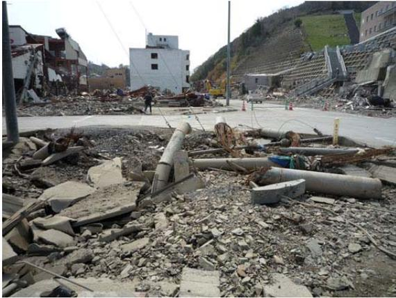
写真 4.4-6 津波で転倒・流された旅館（RC 造 4 階建て）が建っていた敷地：倒れた電柱と紛らわしいが、同建物の杭が残る。
