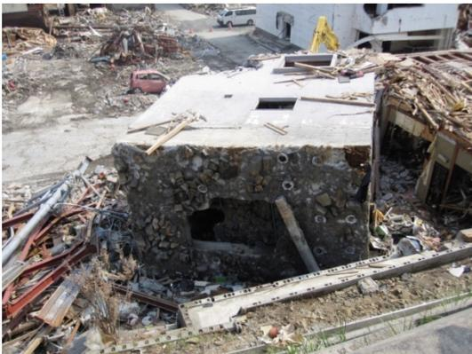
写真 3-12 転倒した 4階建て RC 造建築物
