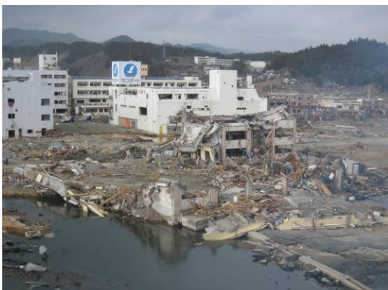
写真 3-20 公民館：3 階建て RC 造、屋根が鉄骨造と思われる。3 階部分が倒壊し、写真手前の体育館が流失している。
