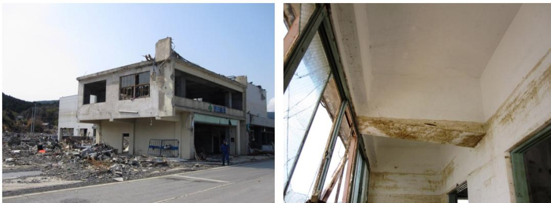
写真 3-14 残存した2階建てRC造建築物
