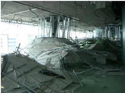
写真 3-27 脱落した天井の様子
