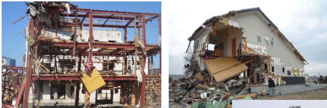
波圧や漂流物の衝突による外装材等の被害
