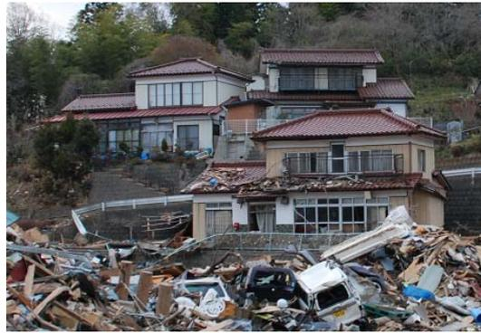
写真 4.3-6 丘陵地の木造住宅。中央の建物は残留物の状況から、2階床上程度まで浸水したものと推察される（南三陸町）
