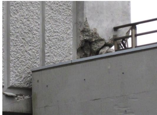
写真 3-22 高層棟 3F 側柱脚部の圧壊
