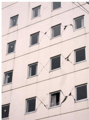
写真 3-52 非構造壁のせん断ひび割れ
