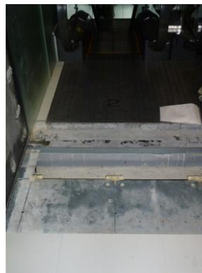
写真 3-34 エスカレーター取り付け部の破壊
