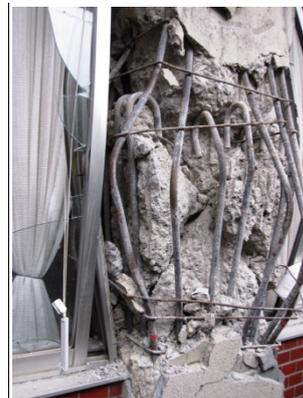
写真 3-51 柱のせん断破壊
