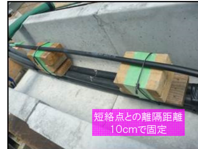
通信ケーブル設置状況(離隔距離10cm)
