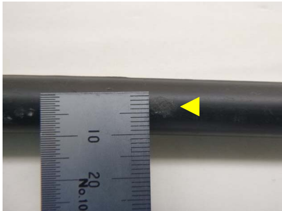
【損傷】傷の大きさ（長さ）5mm
