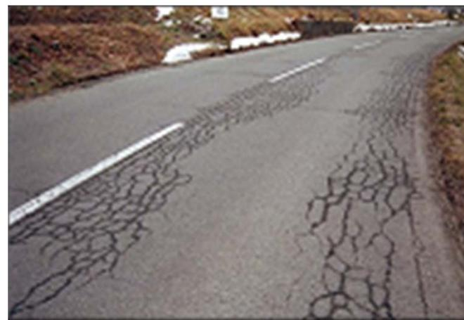
舗装の破損事例(ひび割れ率40%程度)
