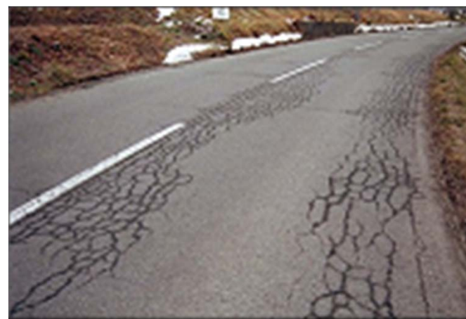
舗装の破損事例(ひび割れ率40%程度)
