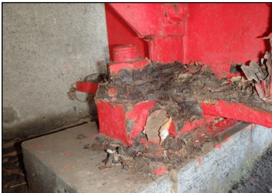
A1橋台 G3桁 (海側の桁)
