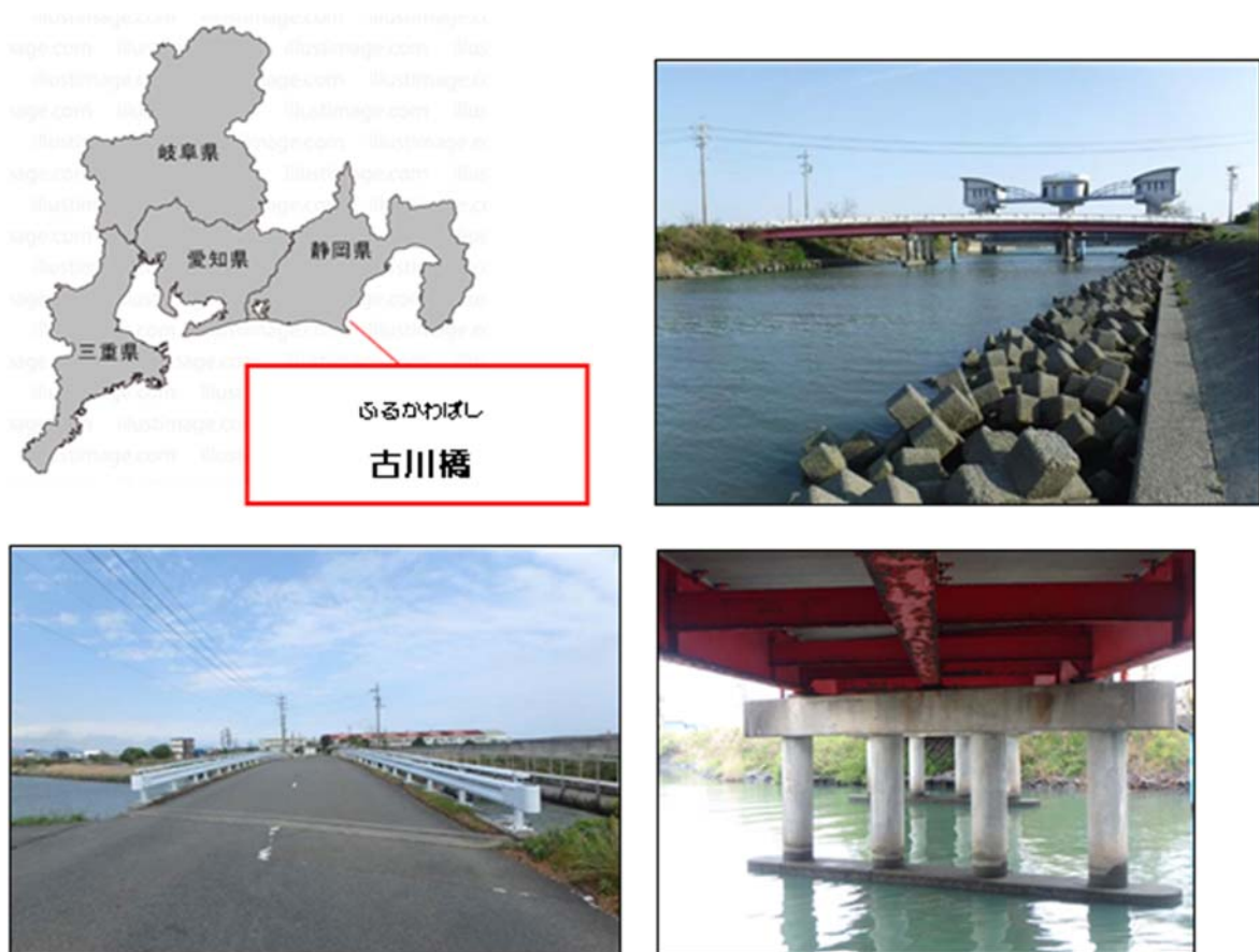
図 1.1 古川橋の位置図と現況写真
