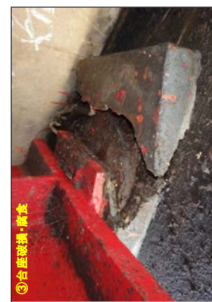
⑥ A1側 沓破損・桁沈下(20mm)
