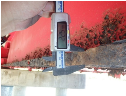
第3径間 主桁下フランジ
