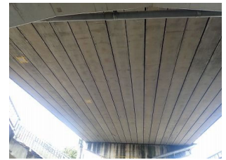
調査箇所全景
