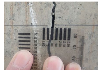
ひびわれ幅 : t = 1.8\text{mm}
