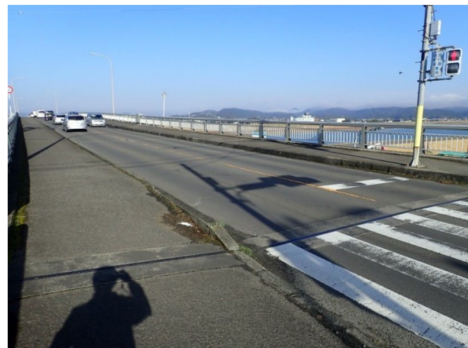
①橋面 (P6-P7) 起点側より
