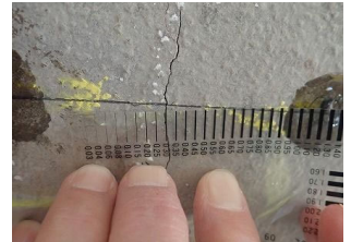
ひびわれ幅 : t = 0.3mm
