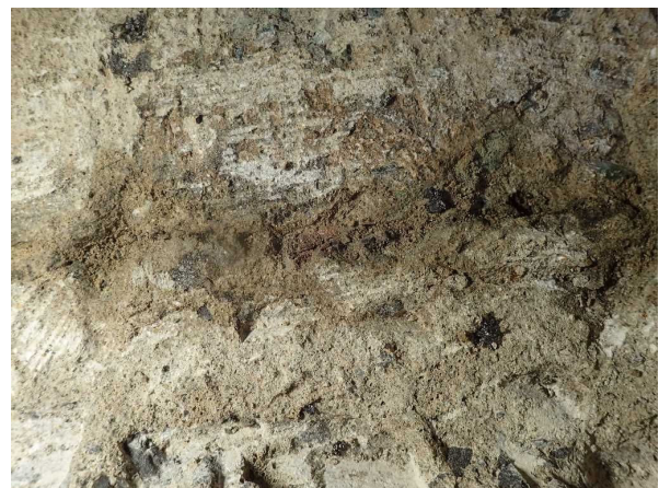
※調整コンクリートにひびわれが見られる。
