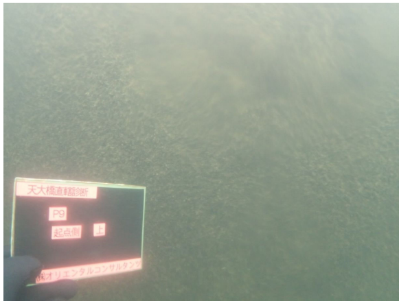
P9 橋脚 起点側 上部
