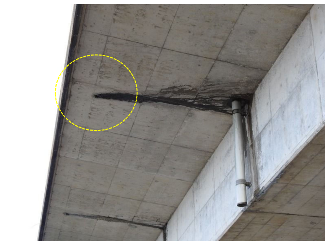
⑤排水装置 (P8-P9)下流側: 床版水抜き孔からの漏水
