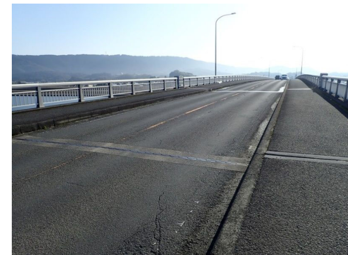
②橋面 (P11-P12) 終点側より
