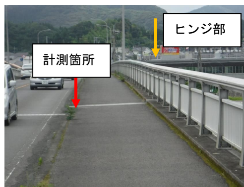
写真一計測対象の橋面
