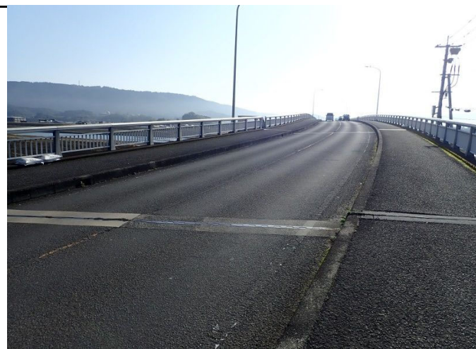
①橋面(P14-P15)終点側より
