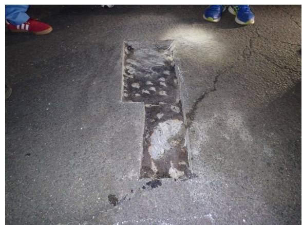
※舗装のひびわれは調整コンに繋がっている
