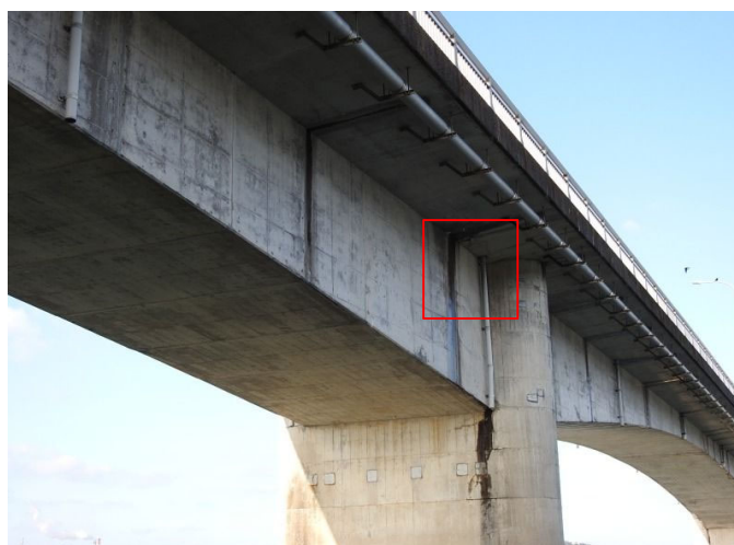
⑦P9、柱頭部全景(上流側より)
