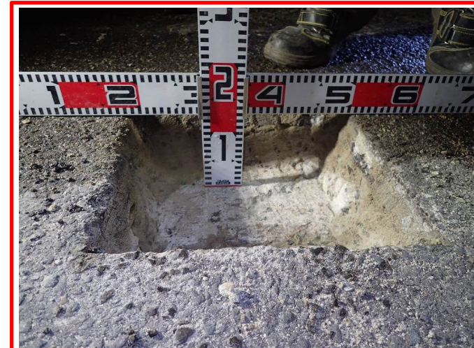
⑥主桁上面の状況 (舗装剥ぎ取り後)
