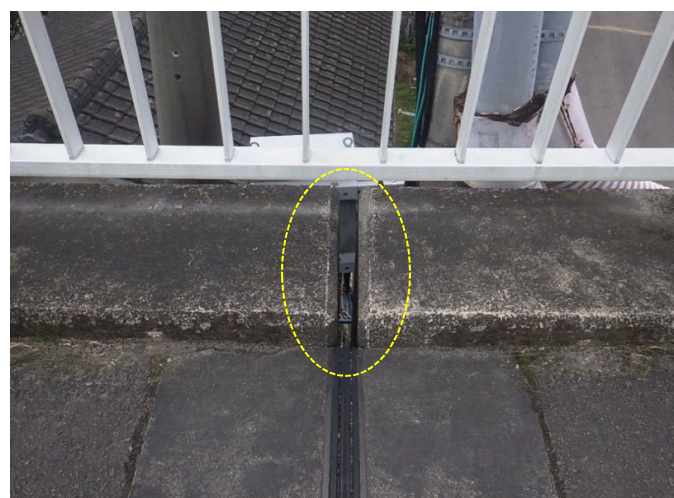
③伸縮装置 (P7下流側): シール材の脱落
