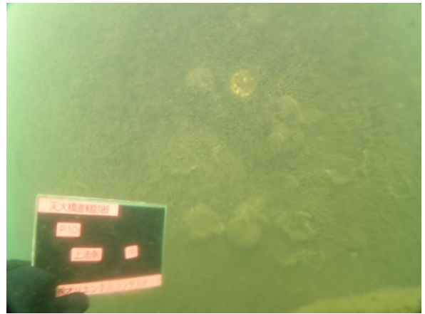
P10 橋脚 上流側 中部
