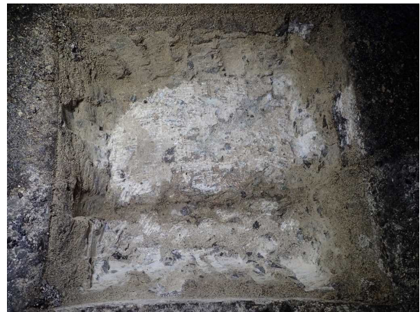
※調整コンクリートにひびわれが見られる。
