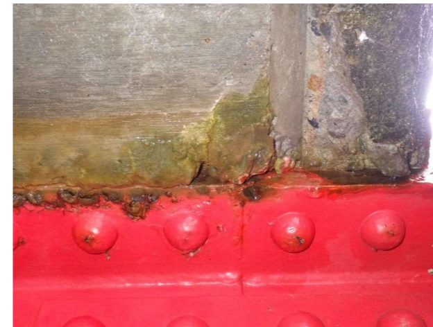
写真-5.2.1 トラス横桁部 (写真番号 1)
