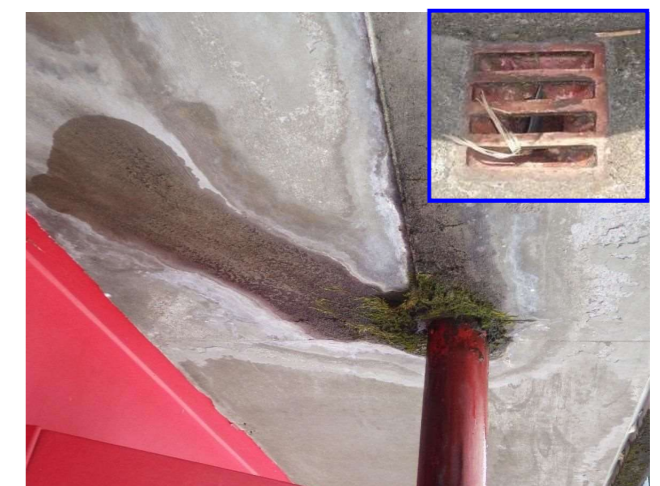
写真-5.2.5 排水管貫通部 (写真番号 5)
