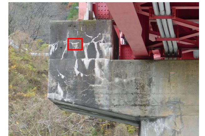
写真-5.3.13 P1 橋脚のはつり位置
