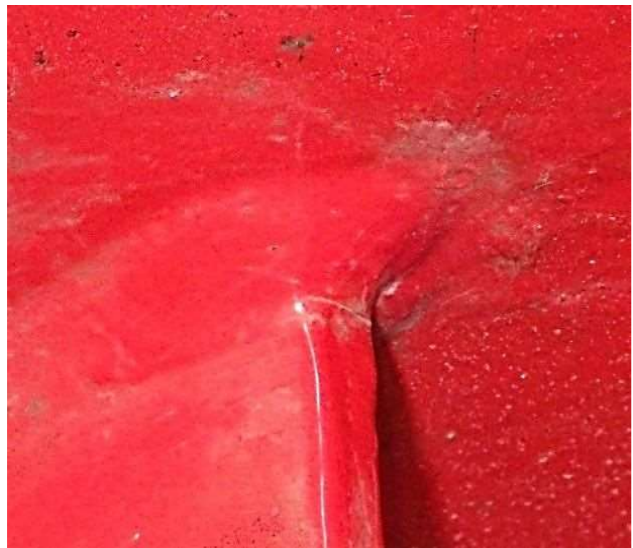
写真-5.1.19 分配横桁取付位置の支点上補剛材と主桁上フランジの溶接部 (写真番号 7)
