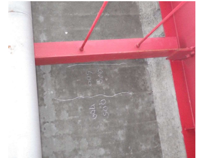
写真-5.2.8 トラスの床版ひびわれ (左：写真番号 8、右：写真番号 9)
