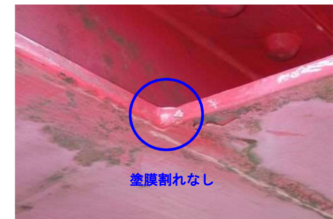
写真-5.1.17 上弦材完全溶込み溶接部 (写真番号5)
