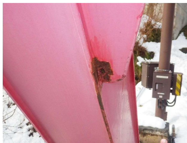
写真-5.1.9 橋門構のウェブ (写真番号 9)
