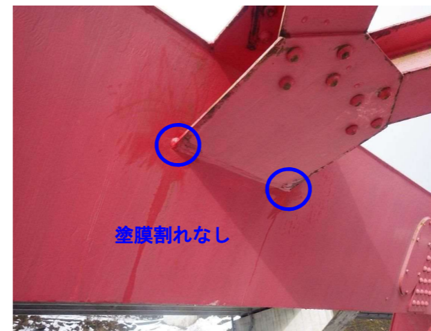
写真-5.1.16 橋門構完全溶込み溶接部 (写真番号4)
