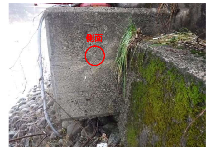
写真-5.3.18 A2 橋台の側面のはつり位置
