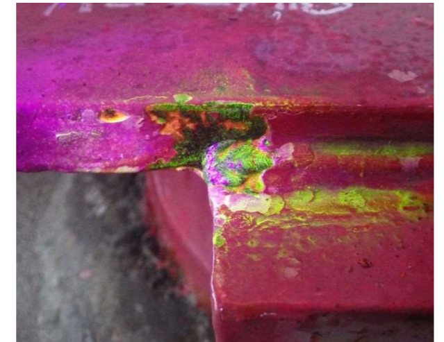
写真-5.1.20 ソールプレートと主桁下フランジの溶接部 (写真番号 8)
