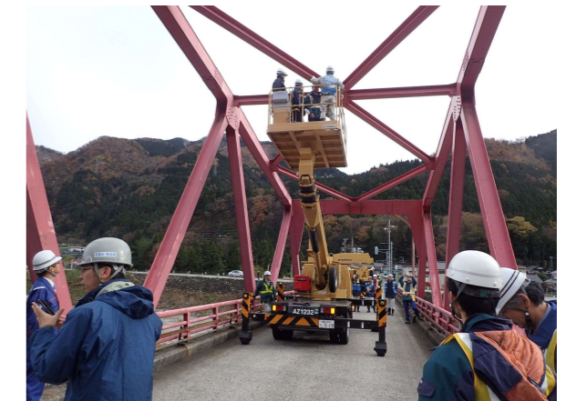
写真-2.2.2 高所作業車による近接目視
