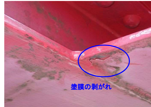
写真-5.1.1 トラス部材の格点部 (写真番号 1)
