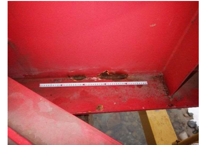
写真-5.1.12 下フランジ溶接部 (写真番号 12)
