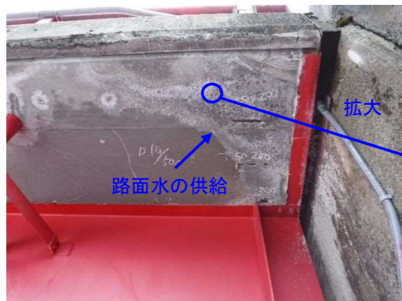
写真-5.2.10 路面水の供給 (写真番号 1)
