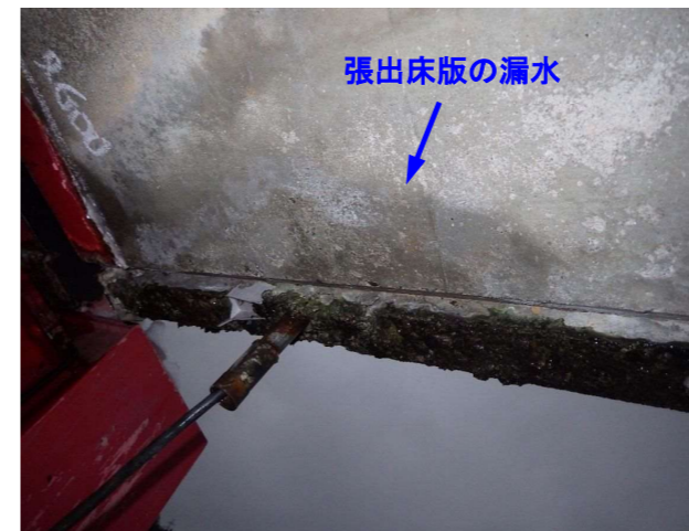
写真-5.2.3 鈹桁張出床版 (写真番号 3)
