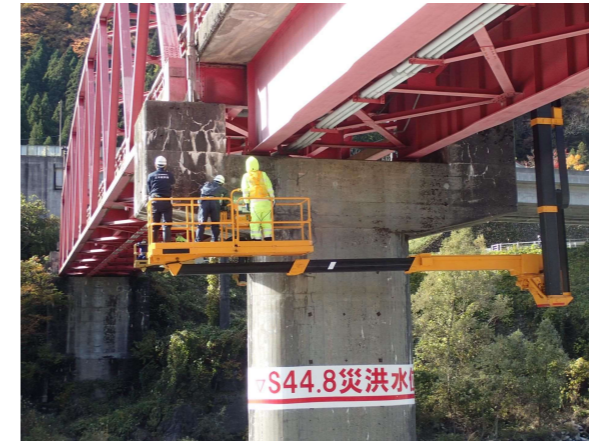
写真-2.2.1 橋梁点検車による近接目視
