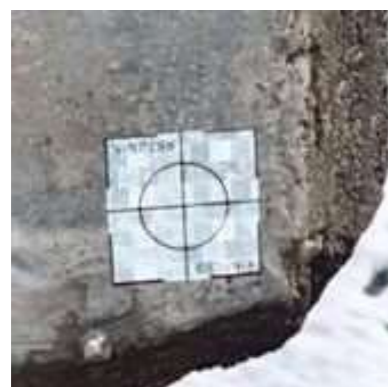
写真-4.4.2 ターゲット貼付け状況
