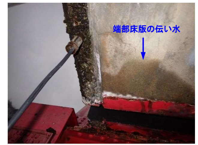
写真-5.2.4 鈹桁端部 (写真番号 4)
