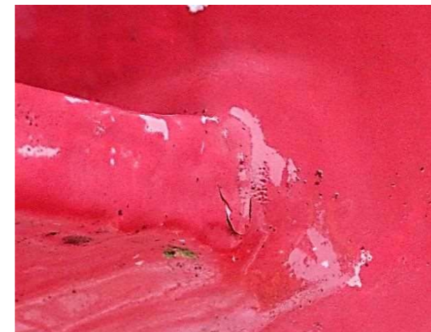
写真-5.1.15 上弦材ウェブと上横構ガセットの完全溶込み溶接部 (写真番号3)
