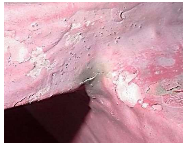
写真-5.1.20 ソールプレートと主桁下フランジの溶接部 (写真番号 8)
