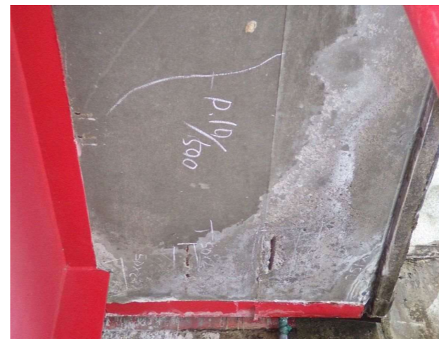
写真-5.2.9 鉸桁の床版ひびわれ (左：写真番号 10、右：写真番号 11)
