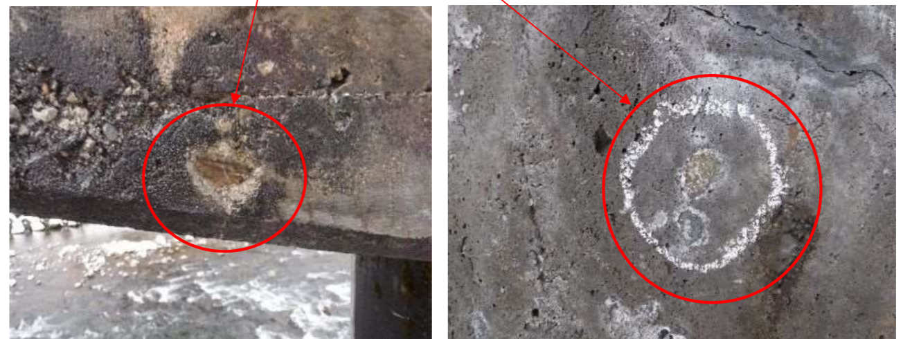
写真-5.3.3 P1 橋脚のコア採取位置（A2側から望む）
