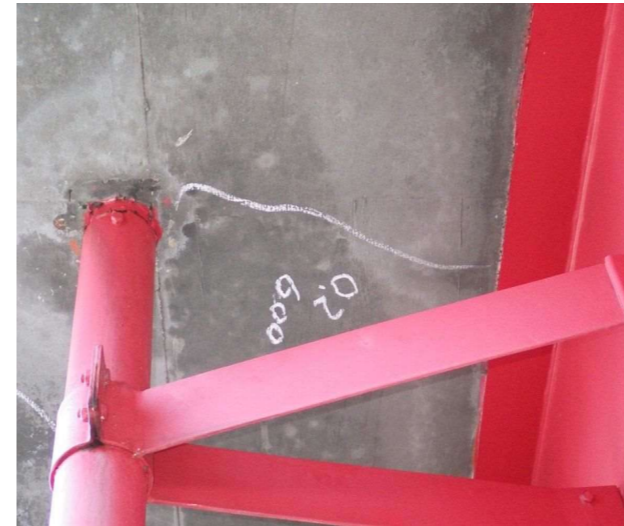
写真-5.2.8 トラスの床版ひびわれ (左：写真番号 8、右：写真番号 9)
