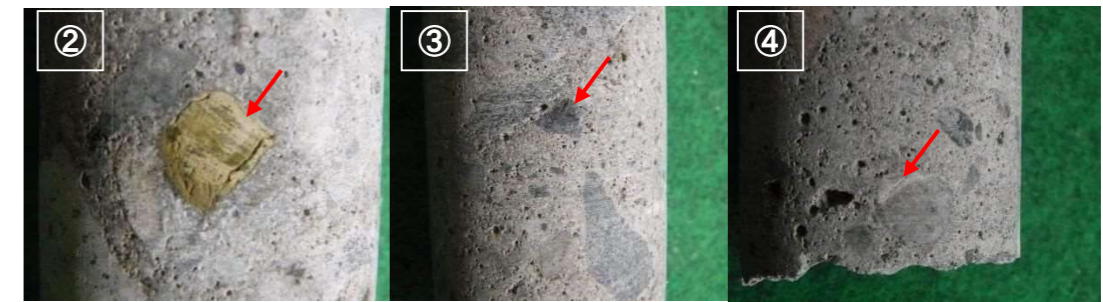
アルカリ骨材反応性のひび割れ ↑
