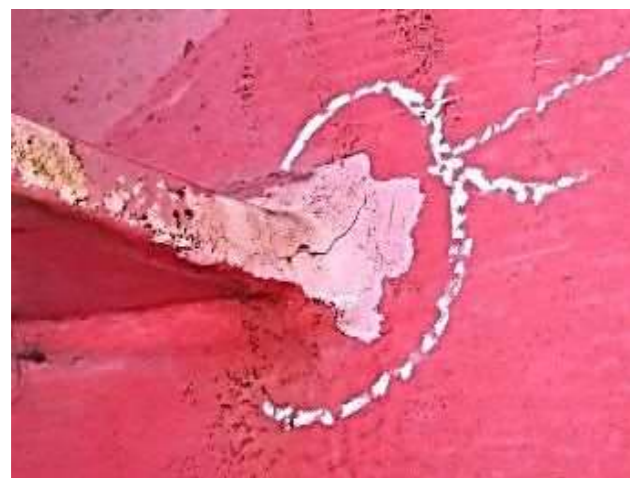
写真-5.1.13 上弦材ウェブと上横構ガセットの完全溶込み溶接部 (写真番号1)
