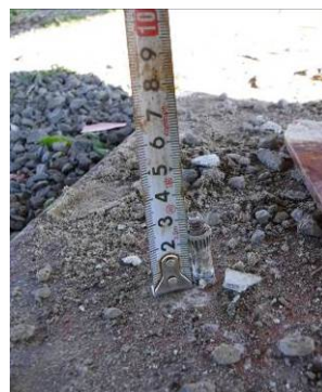
鋼板固定ボルト 根入れ 3cm
