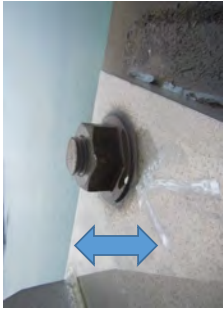
照明柱固定ボルト
