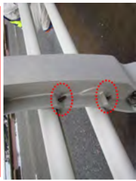
支柱と横梁の接合部
