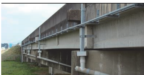
写真-1 橋梁全景
