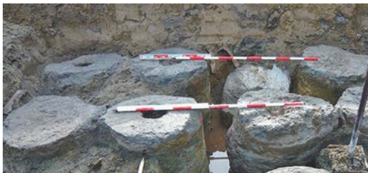
写真-1 改良体確認状況
