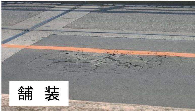
舗装のひびわれ・陥没
