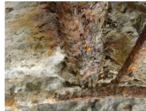
PC鋼材の著しい腐食・破断
