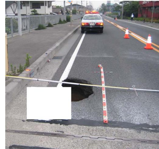
過去に橋台背面で路面陥没
