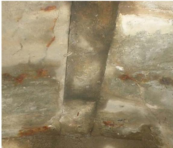
PCT桁の間詰め部での漏水
