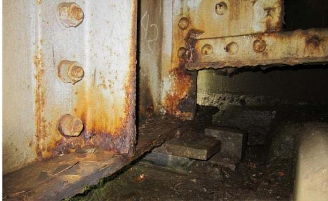
桁端部の腐食
