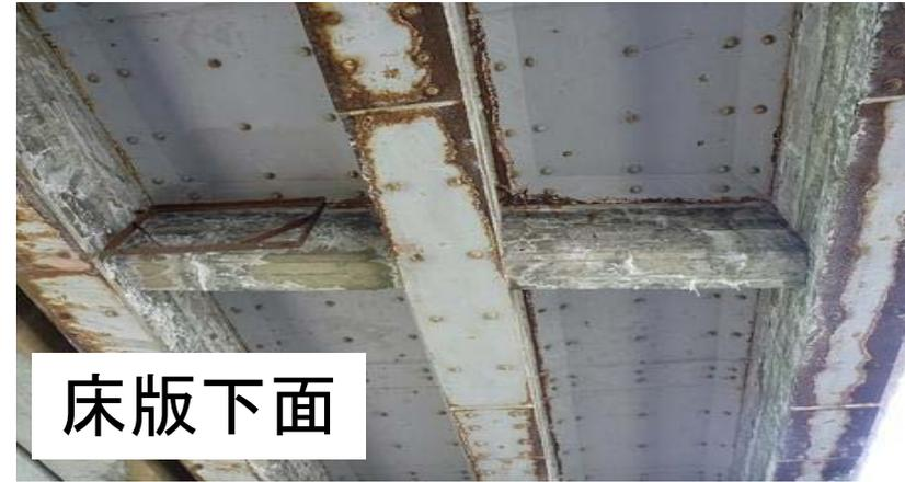
補強鋼板が接着されており、床版コンクリートの状態が不明
