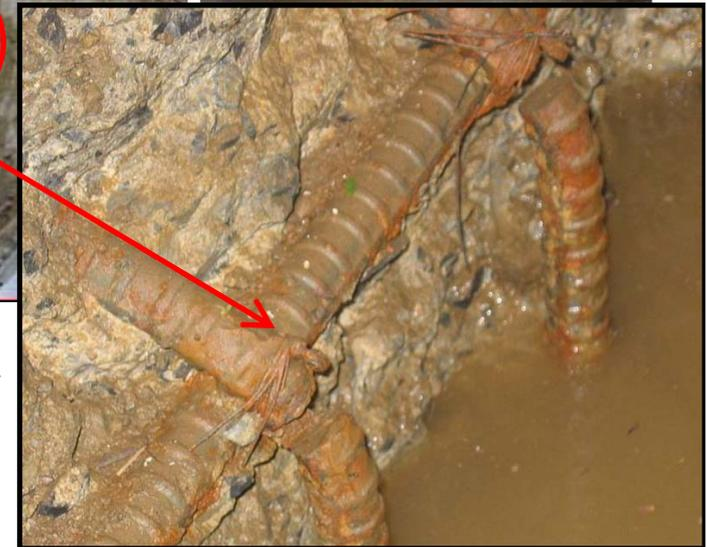
鉄筋破断
