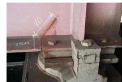
鉛直荷重に抵抗する部材の亀裂：
