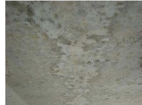
PC箱桁下床版下面に変色部
