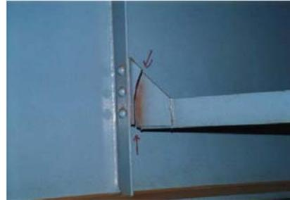
水平荷重に抵抗する部材の亀裂：
