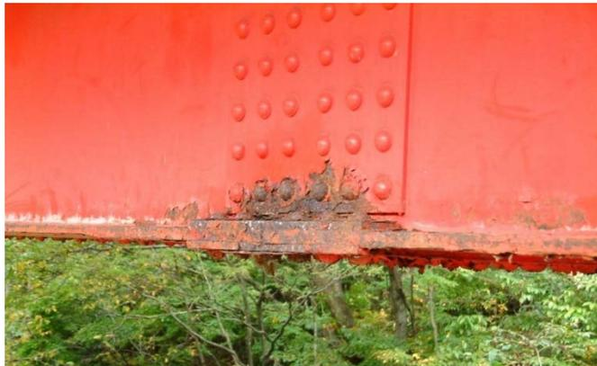
高力ボルト連結部の腐食
