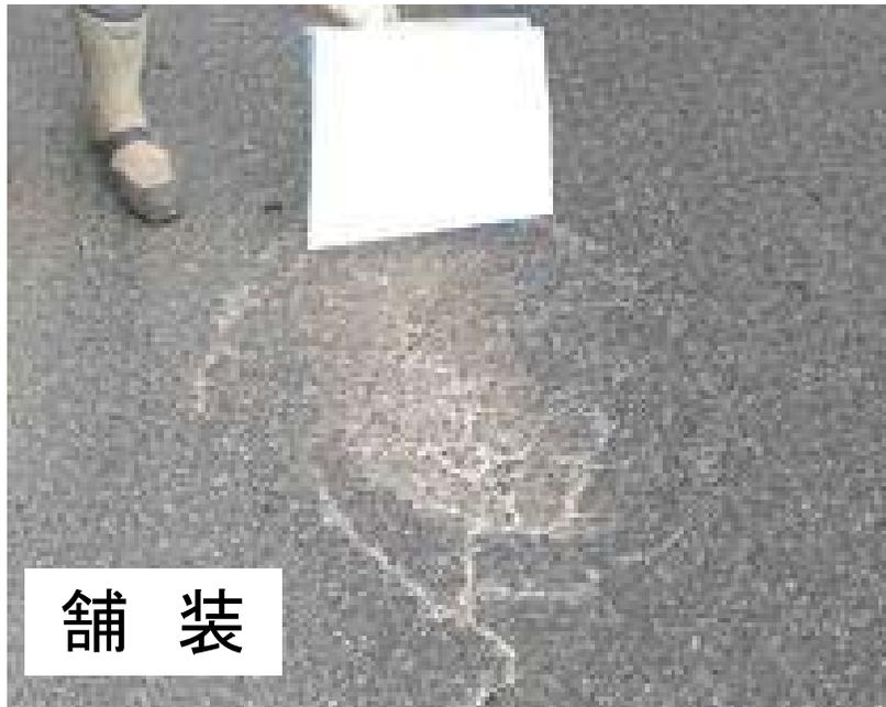
舗装のひびわれ、石灰分浸出
