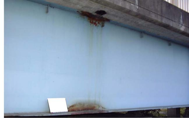
排水装置直下の腐食
