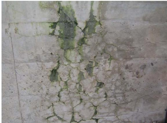
アルカリ骨材反応(ひび割れ)
