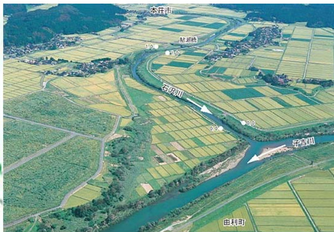
石沢川及び鮎川合流点付近の 平常時の様子
