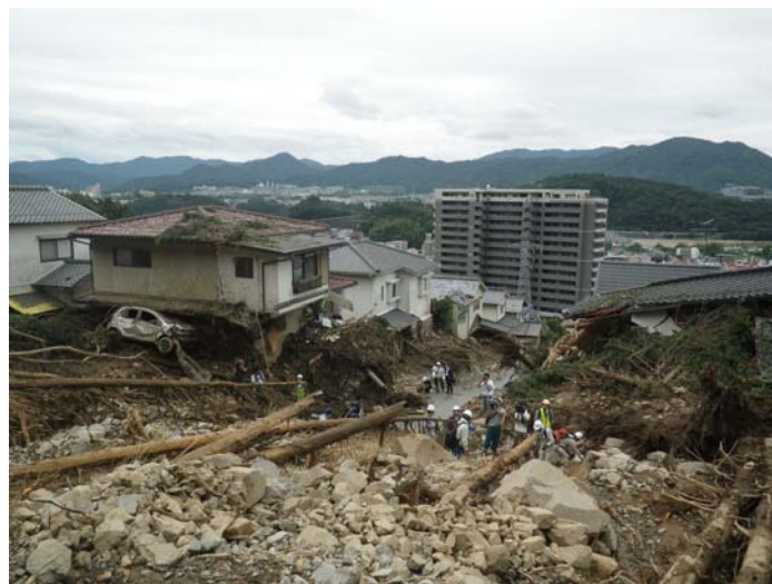
写真6 溪流出口の宅地被災状況
