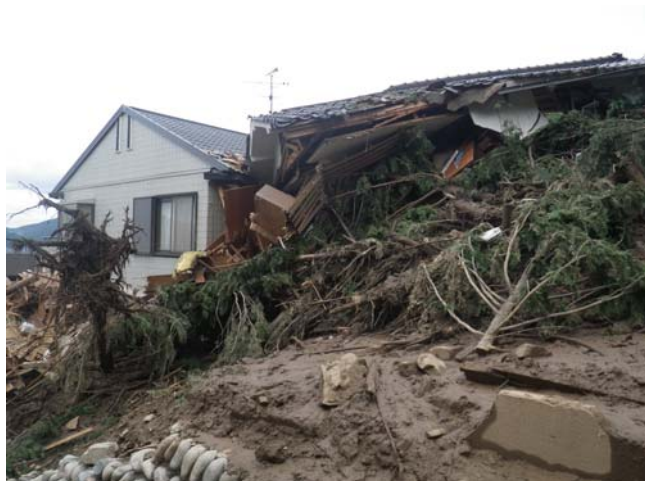
写真8 建物の被災状況
