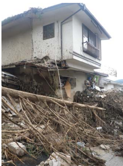
写真7 建物の被災状況
