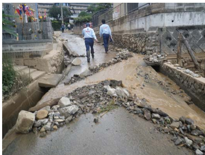
写真9 道路上の流水状況
