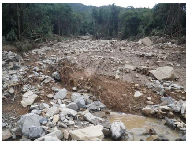
写真3 根茎を残し表層土の流出した地盤と後続流等によると思われる浸食状況
