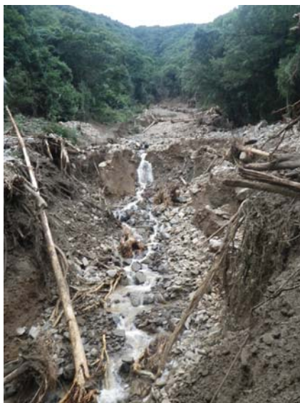
写真2 溪流の濁りの状況と流路部浸食状況
