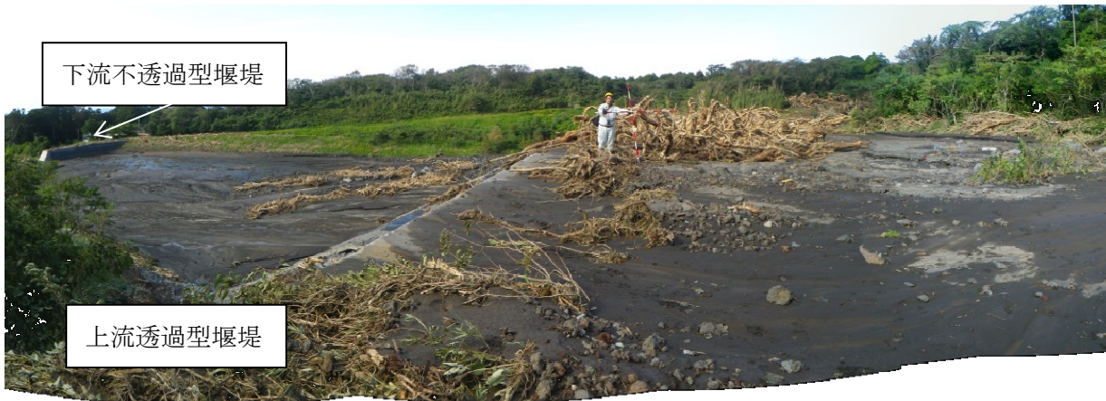
P6 本川堰堤工の堆砂状況
