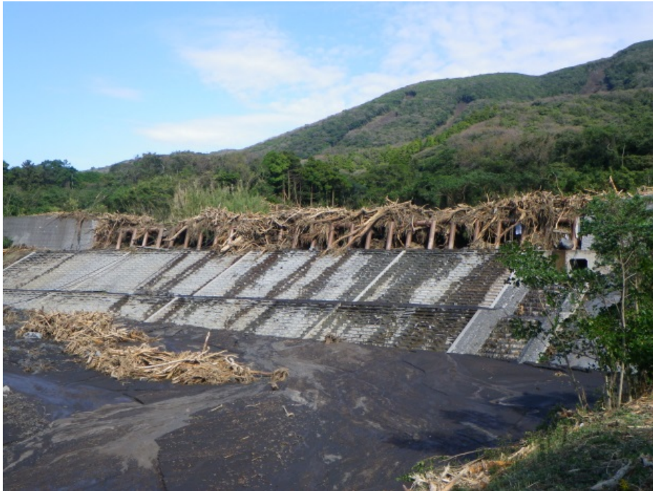
P5 本川堰堤工 透過部が大量な流木により閉塞し、背後に土砂が堆積
