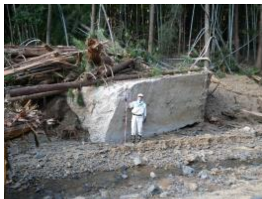
写真 3. 治山堰堤の破損状況
