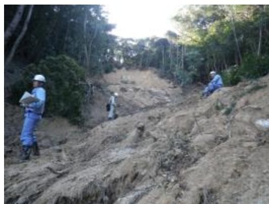
写真 17. 崩壊地の状況 (H=20m、L=40m、W=30m、D=1.5m 程度)
