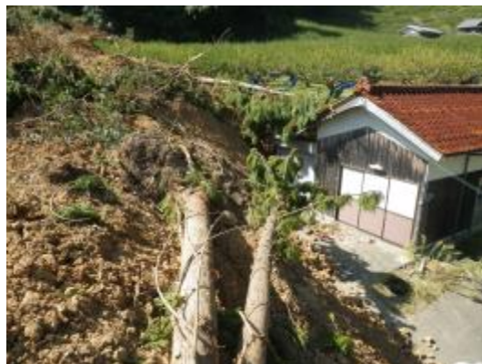
写真 11. 小屋付近の堆積状況
