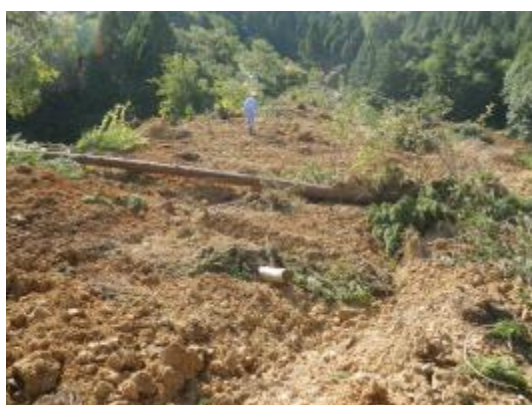
写真 12. 堆積土砂の状況 (下流側から望む)
