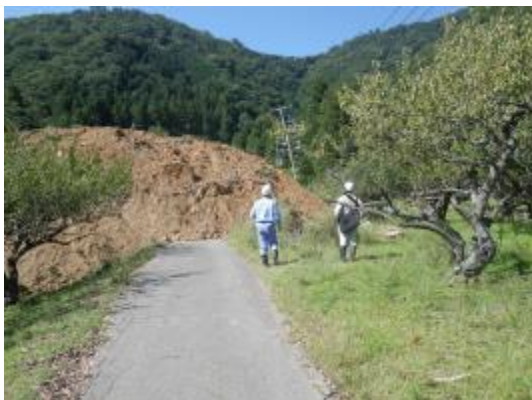
写真 10. 堆積土砂末端部の状況
