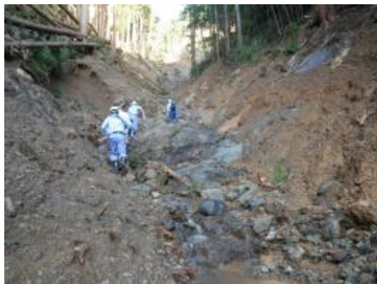
写真 4. 土石流流下区間 (V字谷、溪床露岩、溪床勾配 18° 程度)
