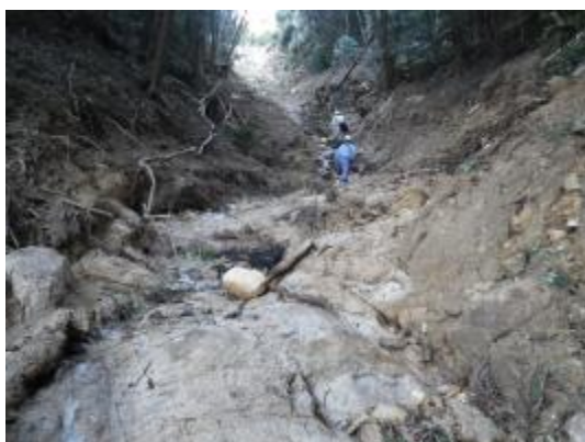
写真 16. 流下区間の状況 (溪床は露岩、溪床勾配 25~30° 程度)
