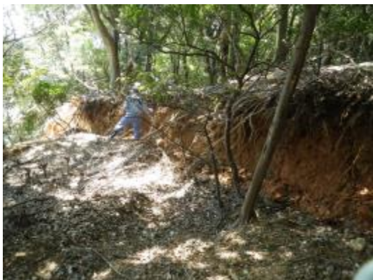
写真 8. 滑落崖縁辺部の変位状況 (比高 1～2 m 程度)
