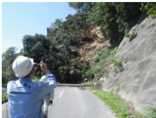
写真 7. 崩土による道路寸断
