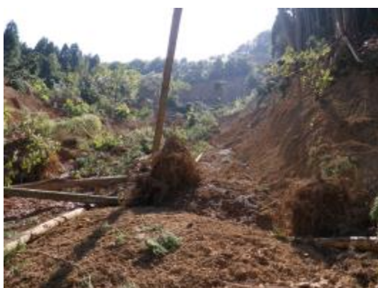
写真 13. 崩壊地及び流下区間の状況
