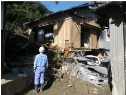
写真 14. 人家の被害状況
