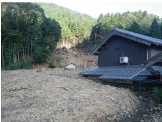
写真 2. 谷出口付近の流出土砂堆積状況 (家屋の倒壊なし。1階部分を土砂が通過)
