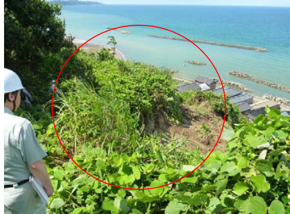
写真4 崩壊源頭部と斜面上部の緩斜面(赤丸)
