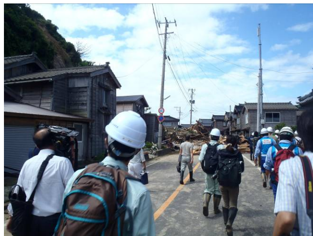
写真2 国道402号の状況
