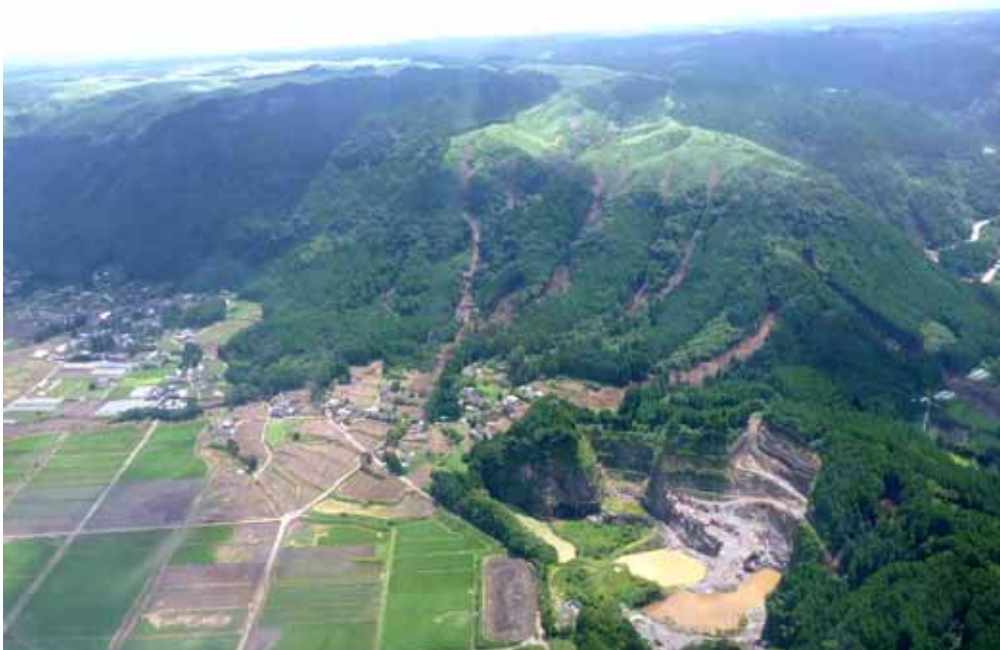
坂梨北地区。卵の鼻の北西の斜面に崩壊が集中している。
