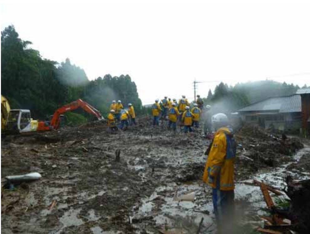
三久保地区崩壊斜面下流側。粒径が細かく含水率が高い流動化した土砂が厚く堆積する。
