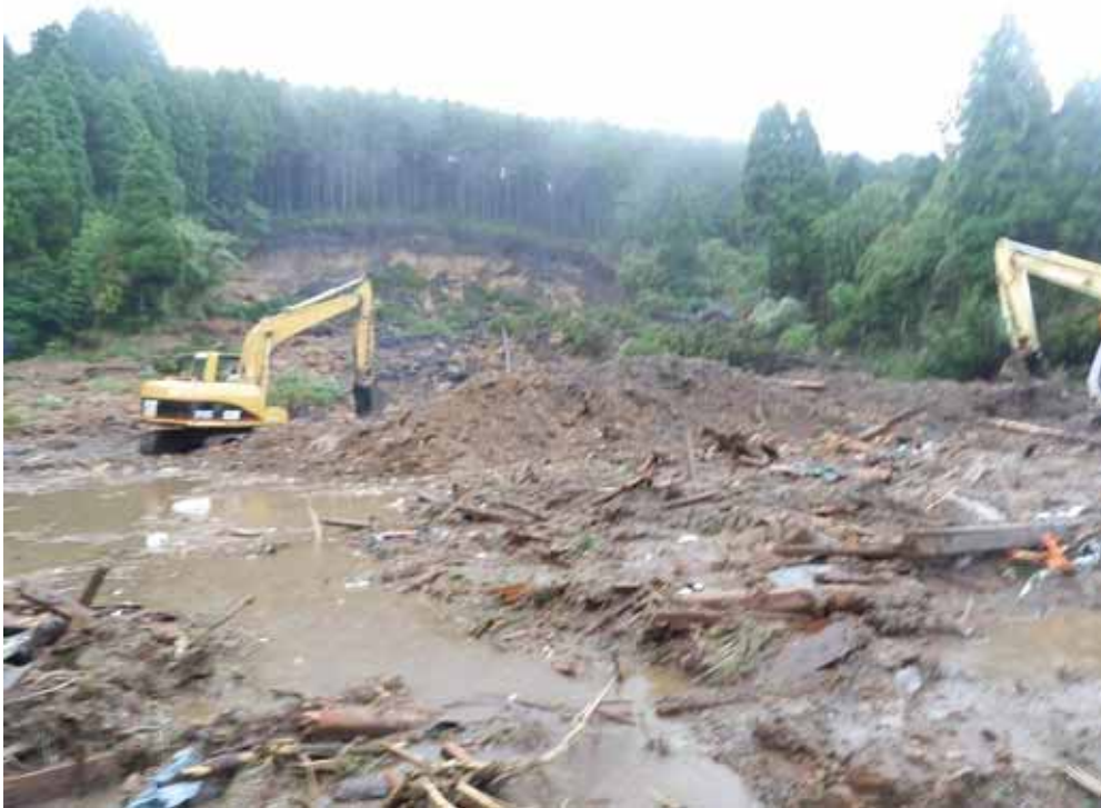
三久保地区崩壊斜面の状況。滑落崖の高さ約 20m に対して、崩壊土砂の堆積範囲が 120m 程度と到達範囲が非常に広い。
