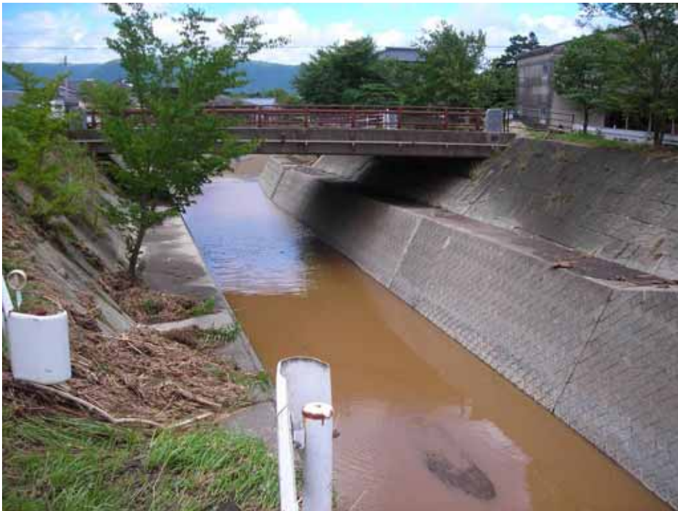
国道 57 号線横過部の流路工の状況(上流から下流を望む)
