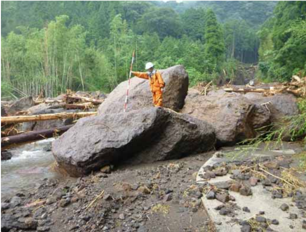
塩井川砂防ダム堆砂敷の状況。巨礫が捕捉されている。
