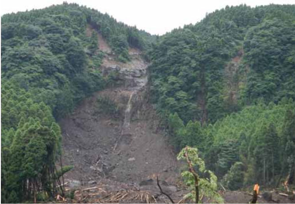
崩壊が発生した斜面。H=50～60m。斜面上部が滝状に残り、滝の下流側が急勾配に侵食されている。
