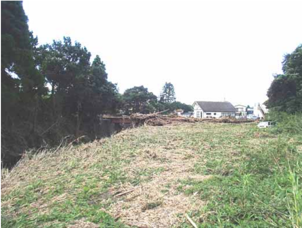
JR 橋横過部を上流から望む(遠景)。橋梁に流木が堆積している。
