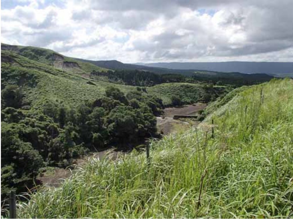
中流域の堰堤の状況(右岸より下流を望む)。著しい侵食、山腹崩壊は認められない。
