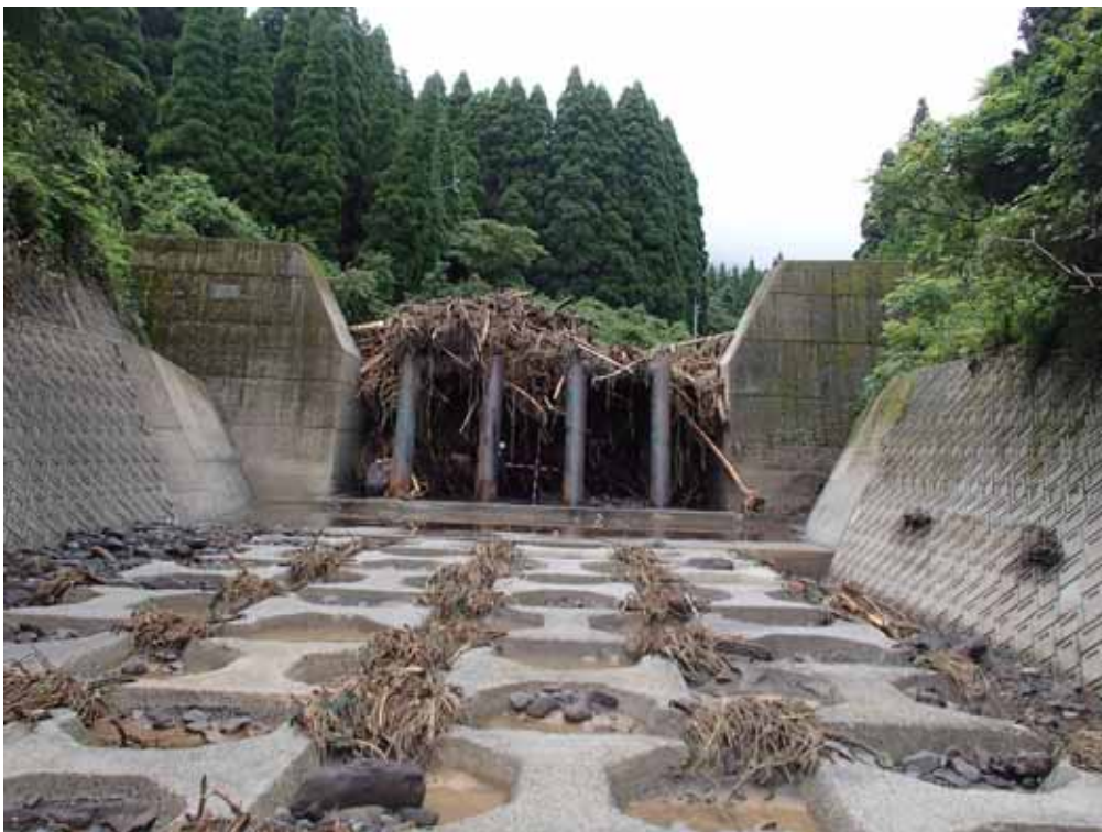
D6 透過型砂防堰堤に土砂・流木が捕捉されている。
