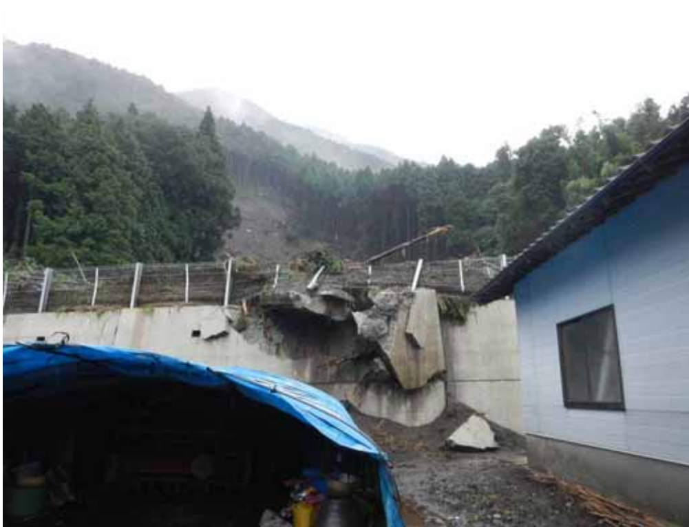
新所地区 立野地区急傾斜地危険箇所に設置された重力式擁壁。上方で斜面崩壊が発生し、擁壁が一部損壊。
