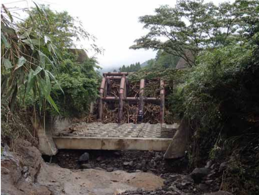
D5 透過型砂防堰堤に土砂・流木が捕捉されている。
