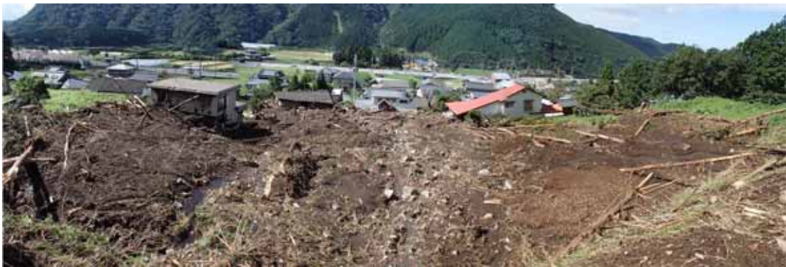
新所地区 崩土堆積域の状況（上流から下流を望む）
