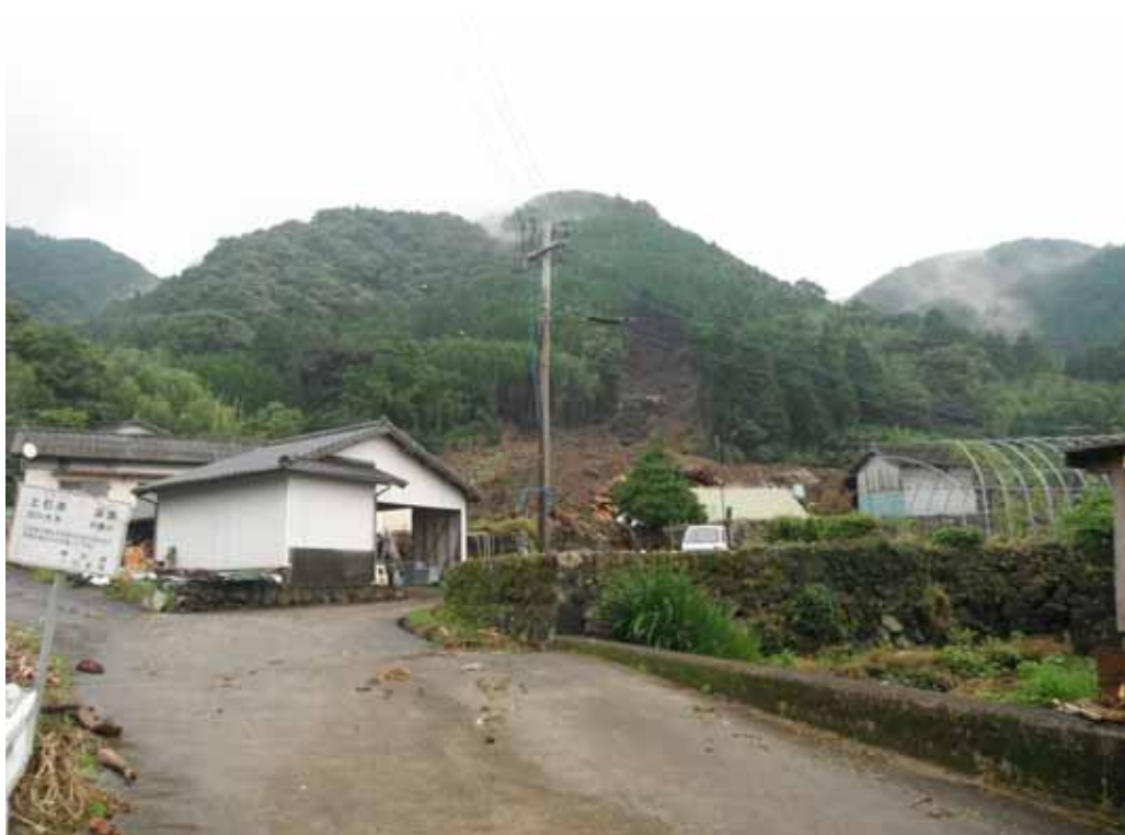
五の二区崩壊斜面全景。崩壊源頭は山腹斜面の中腹にある。
