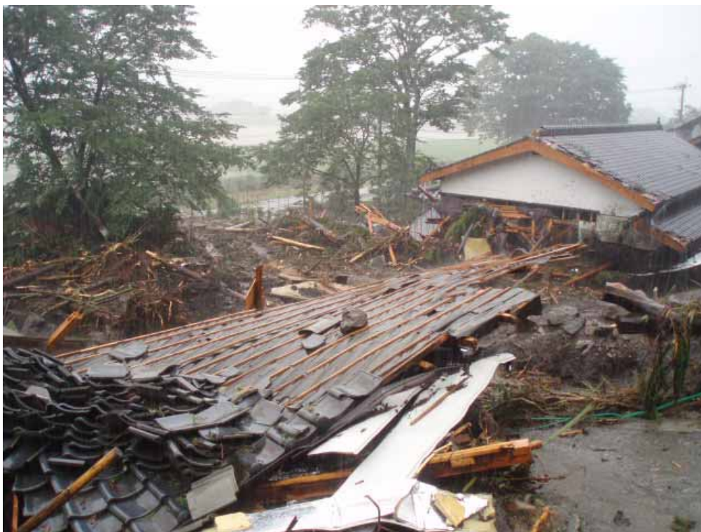
三閑地区（崩壊その1）被災状況。土砂、流木により家屋が倒壊。
