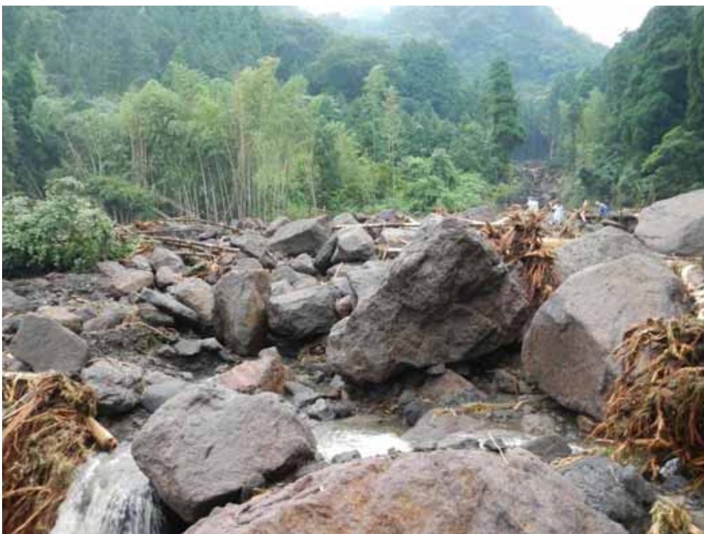
塩井川砂防ダム堆砂敷。巨礫が厚く堆積している。堆砂勾配は6°程度。
