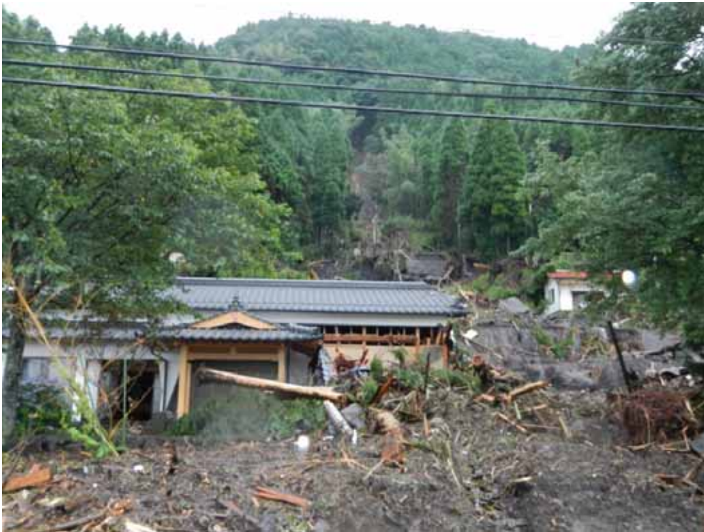
三閑地区（崩壊その1）斜面崩壊の概観。斜面の比較的低い位置より崩壊が発生。
