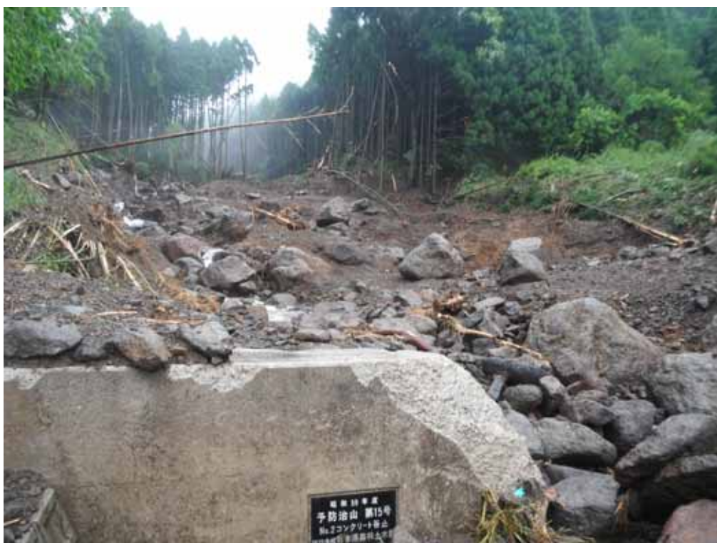
治山堰堤の水通しが破損しているが、巨礫を含む土砂が堆積している。
