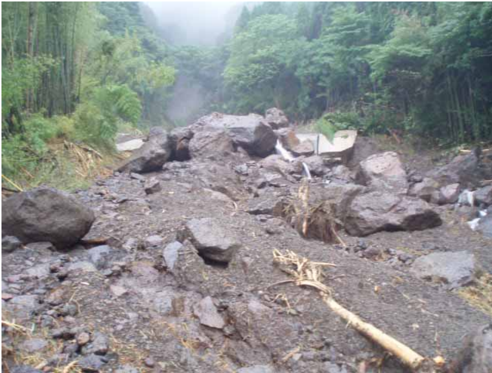
上流の治山床固工が倒壊している。巨礫、流木、細粒の土砂が急勾配で堆積。
