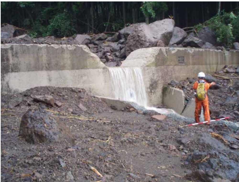
治山床固工。天端が著しく磨耗しているが、土砂の一部を捕捉。
