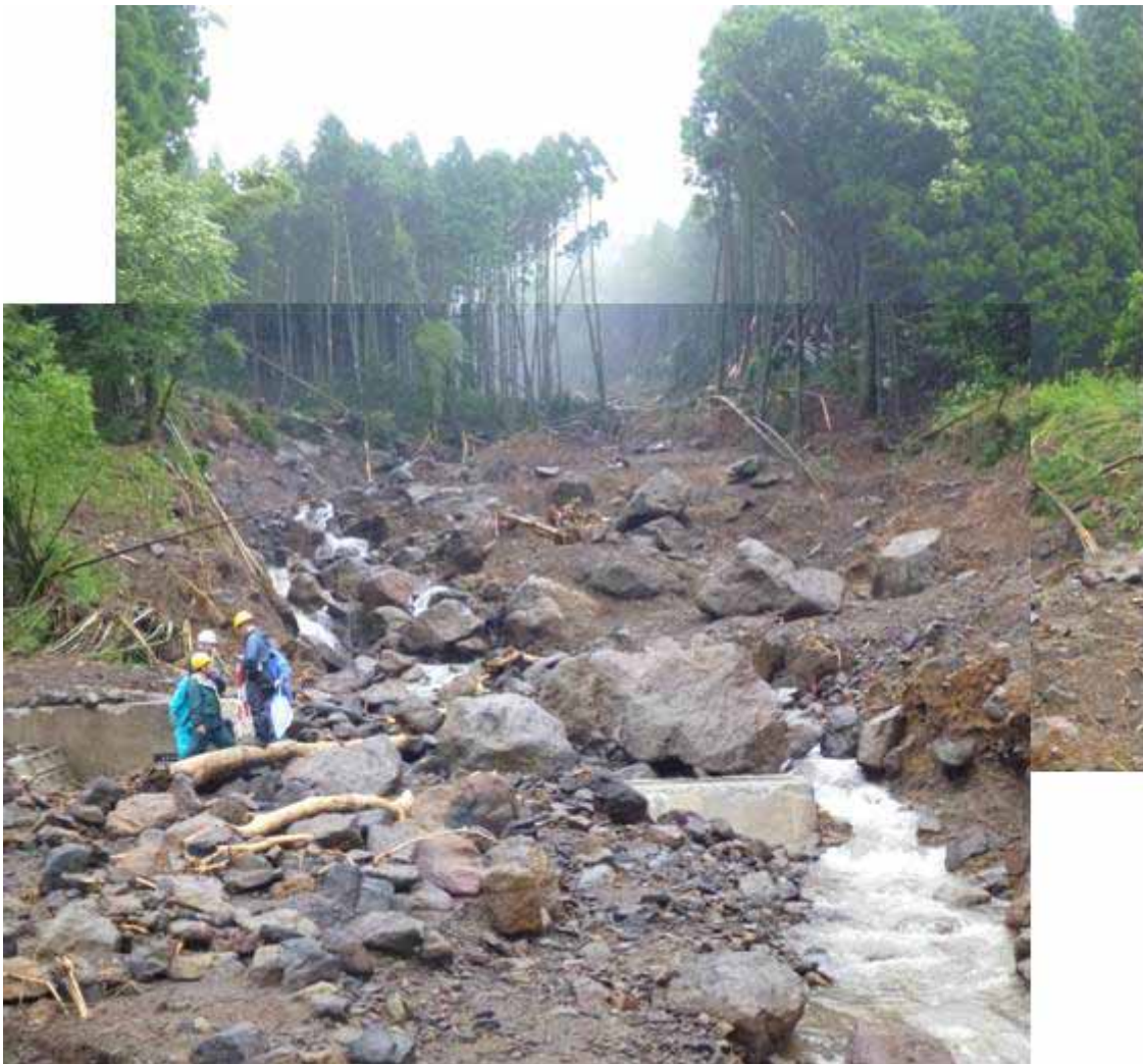
治山堰堤より上流を望む。治山施設は流出土砂により倒壊、一部埋没している。
