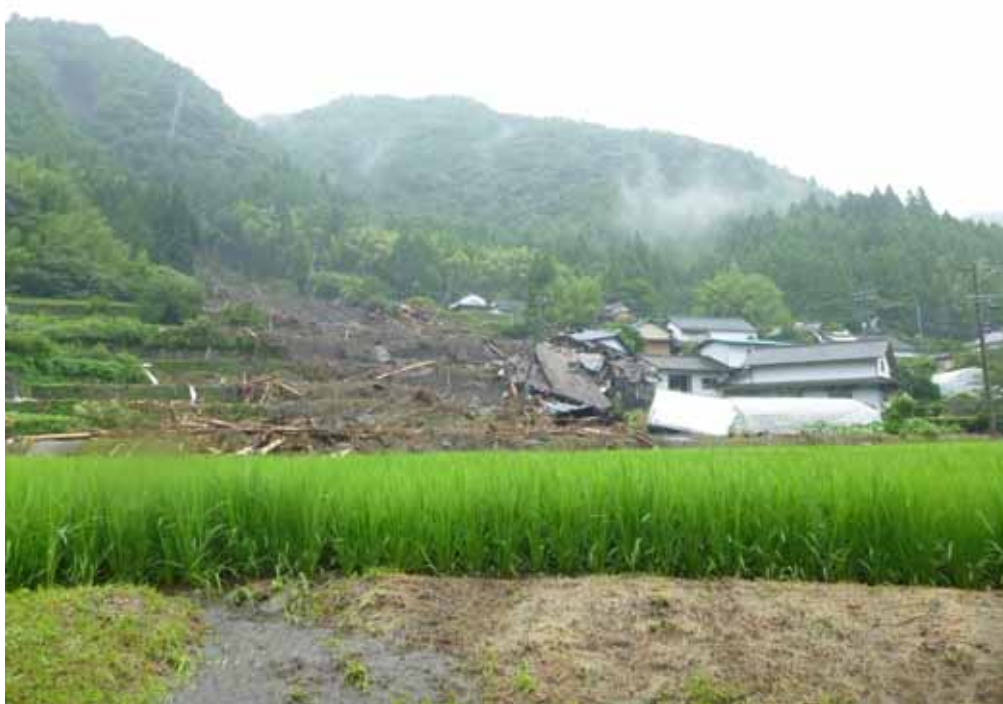
手野 地区の土石流堆積状況。土砂と流木が集落方向へ流出。巨礫は目立たない。
