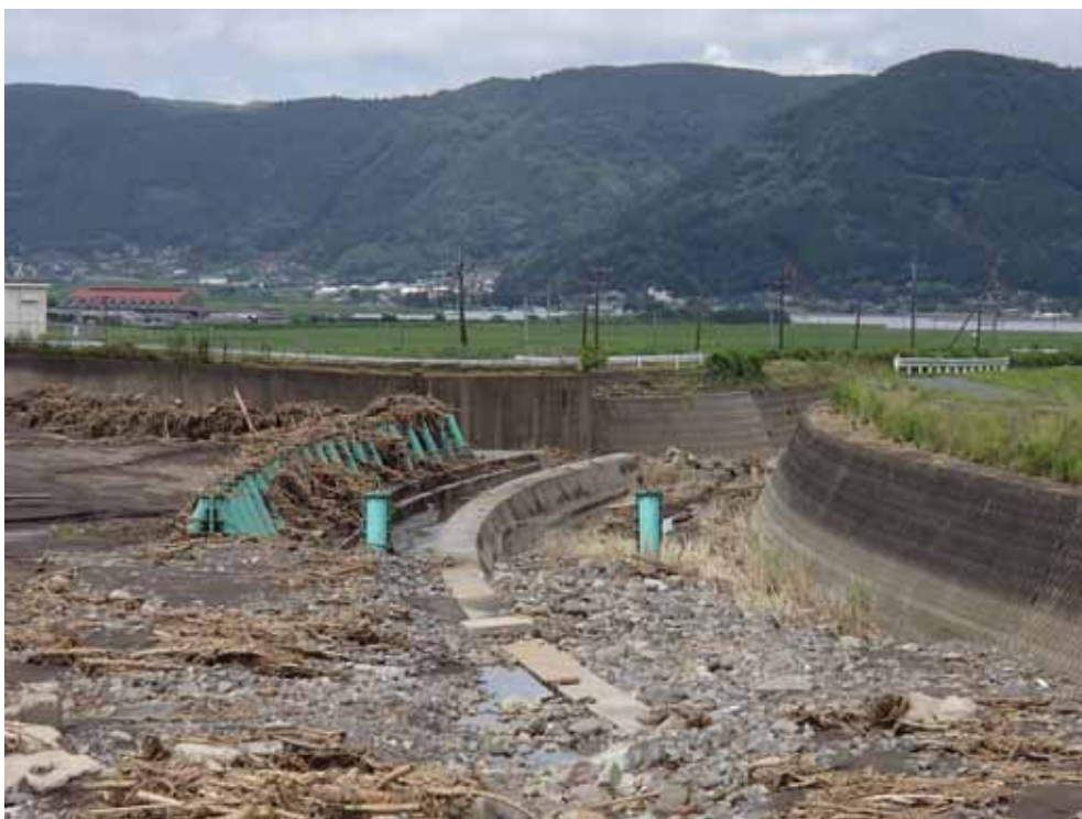
多目的貯木池内の A 型鋼製スリットにより流木が捕捉されている。
