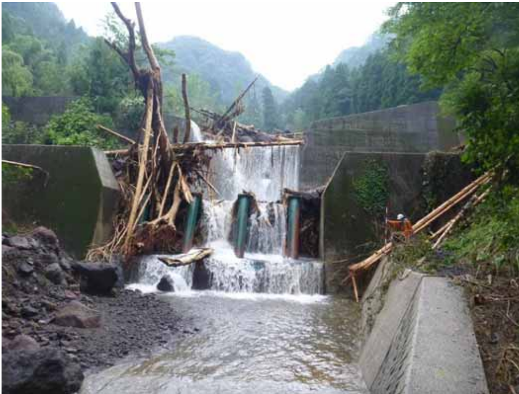
塩井川砂防ダム（県土木）土砂・流木が捕捉されている。
