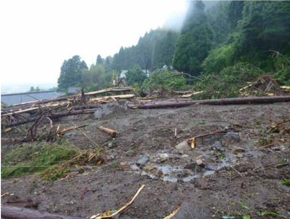
三野地区下流側堆積状況。細粒分が多く、水分も多い。
