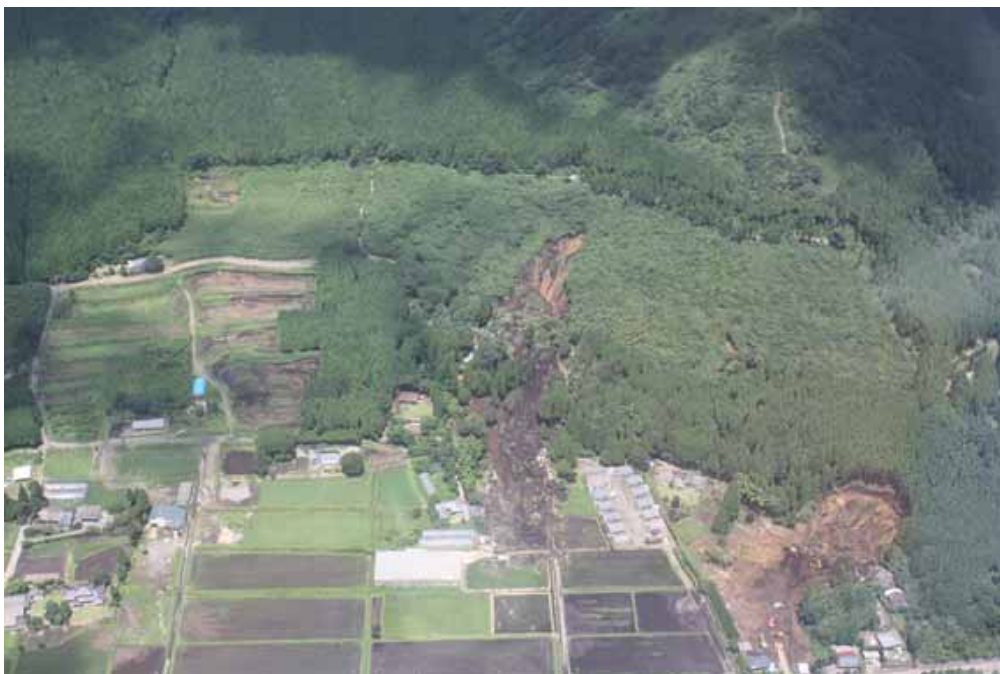
三久保地区 隣接する2か所で地すべり性の崩壊が発生し、人的被害・家屋被害が発生。
