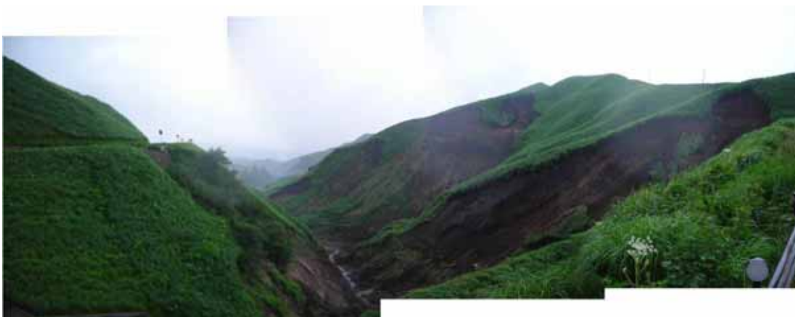
右支川上流端より下流を望む(表層崩壊が多数発生)
