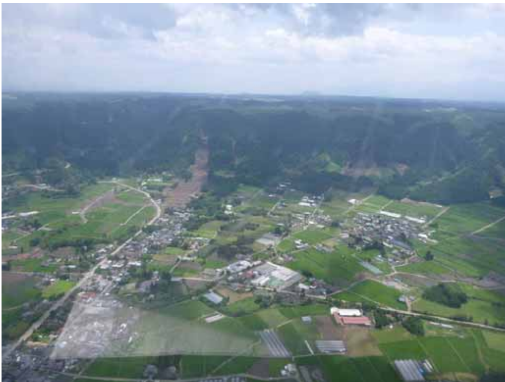
坂梨地区全景。国道 57 号西側に崩壊が多発。
