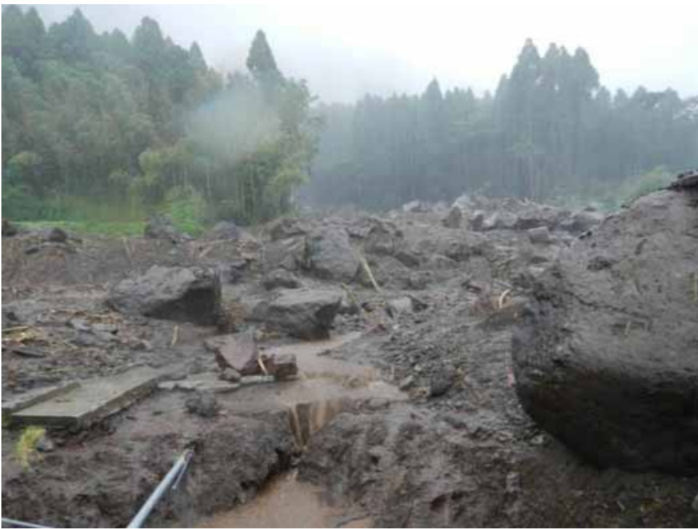
治山床固工下流の状況。広い範囲に巨礫、細粒土砂が堆積。
