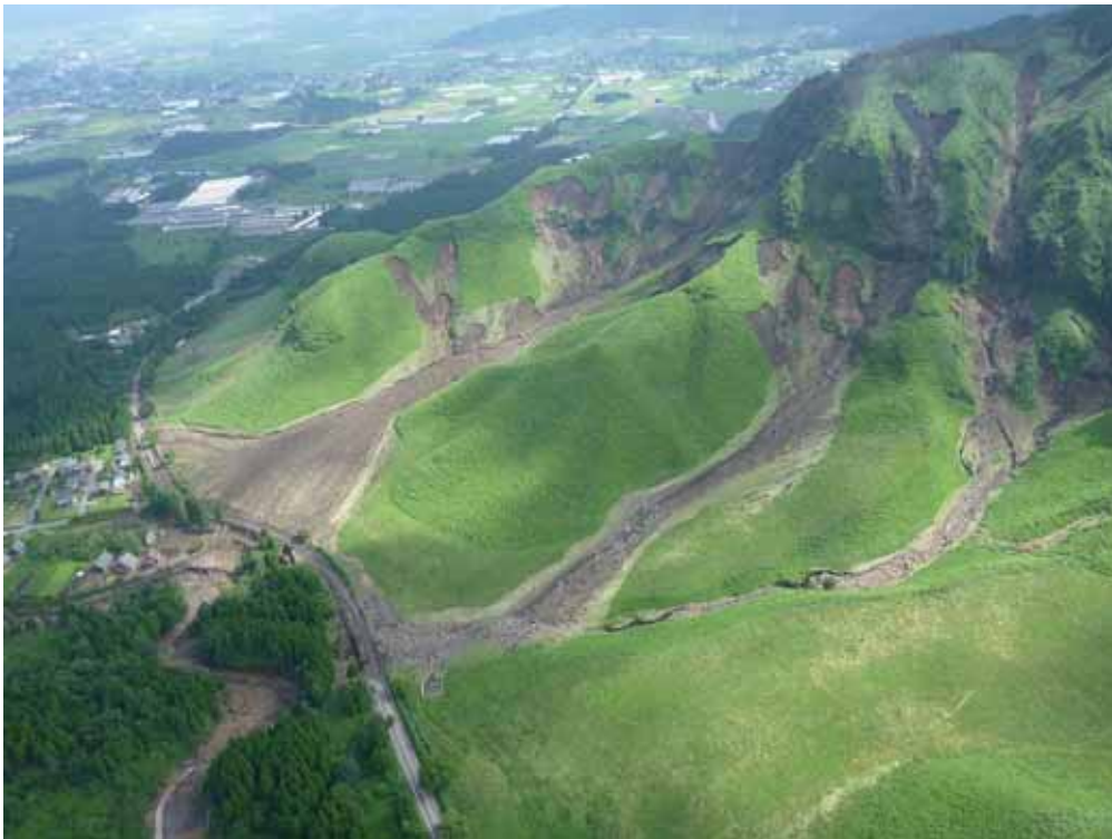
斜面から崩壊した土砂が国道 265 号へ到達している。新規拡大崩壊によるものと思われる。
