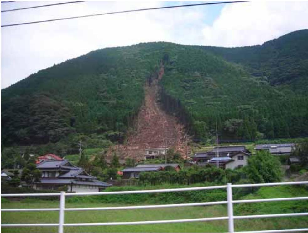
新所地区 崩壊地全景
