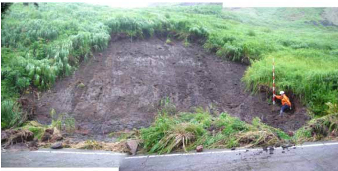
国道 265 沿いの小さな表層崩壊(全景)。
