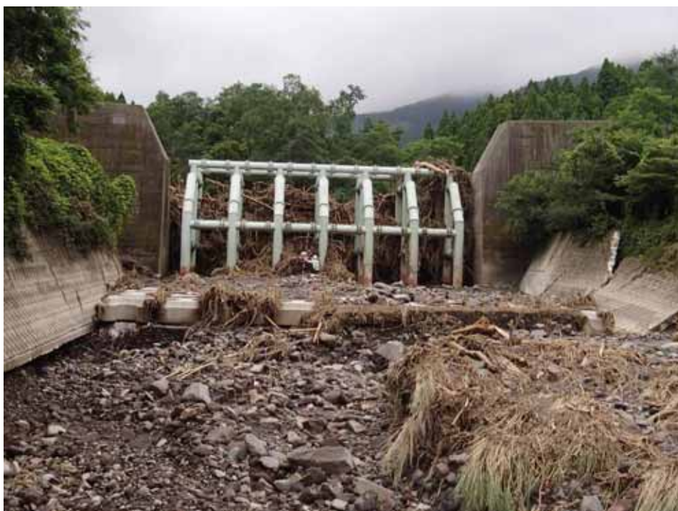
D4 透過型砂防堰堤に土砂・流木が捕捉されている。
