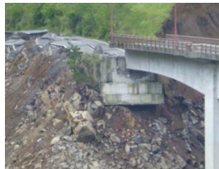
斜面崩落による橋台の沈下
