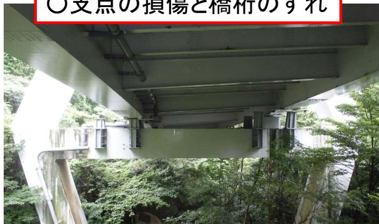
○支点の損傷と橋桁の浮き上がり
