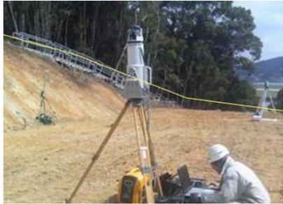
短時間で施工箇所の3次元測量を実施
