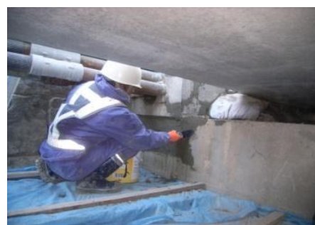
断面修復作業
