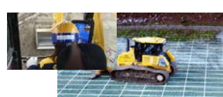
ICT建機による施工
