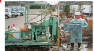
薬液注入状況
