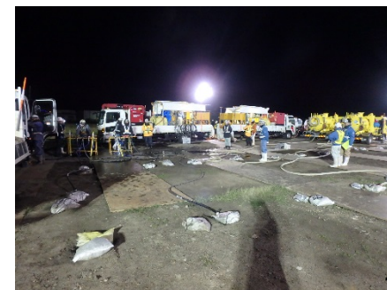
ベントナイト注入状況確認
