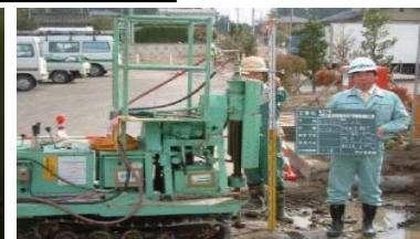
薬液注入状況
