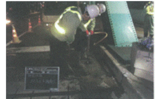
試掘による舗装の健全度調査
