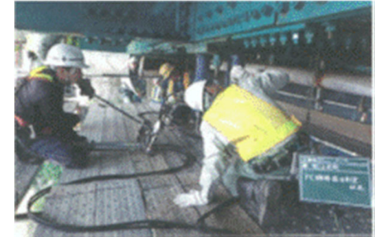
足場を用いた健全度調査
