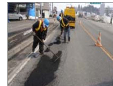
舗装版舗設作業
