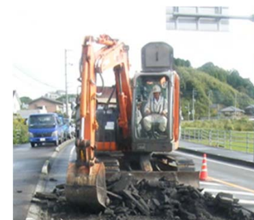
舗装版破碎作業
