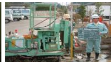
薬液注入状況
