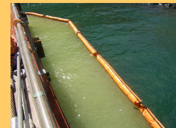
[ 汚濁拡散防止膜による拡散防止状況 ]
