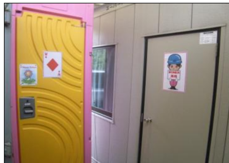
更衣室、トイレの設置
