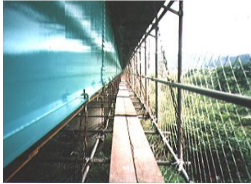
側面塗装足場の例
