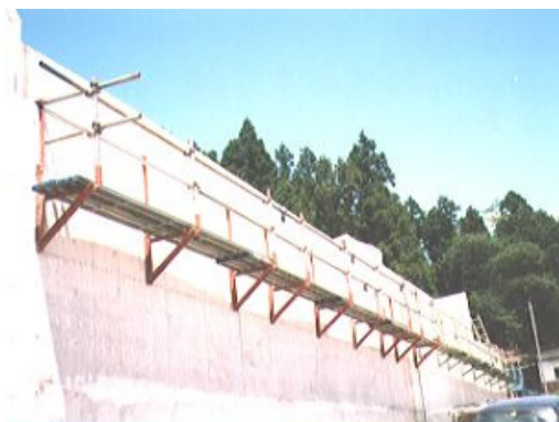
支承設置用足場の例
