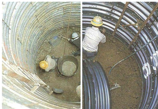
人力作業による排土作業・ライナープレートの組立作業 【出典:改訂3版土木施工の実際と解説】
