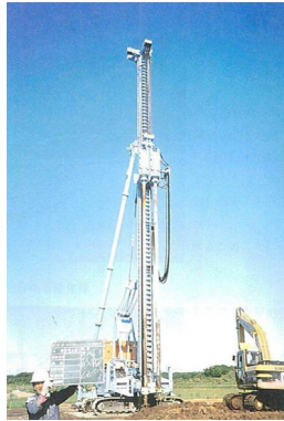
深層混合処理機（二軸施工）の例 【出典：改訂3版土木施工の実際と解説】
