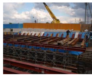
支保工設置の地耐力の確認
