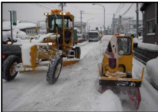
除雪作業状況
