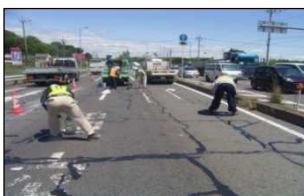
シール材注入
