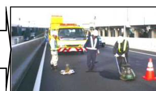
路面補修(パッチング処理)
