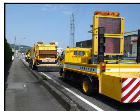
路面清掃作業状況
