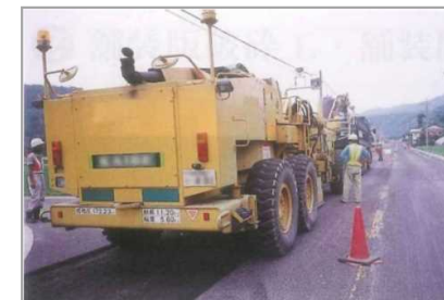
路面切削作業
