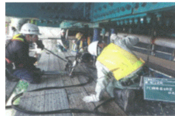
足場を用いた健全度調査
