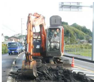
舗装版破碎作業
