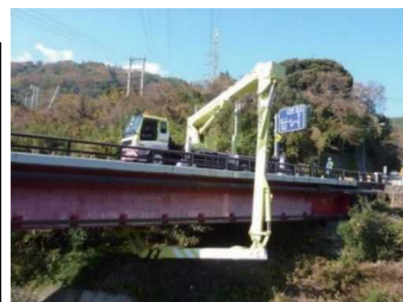
橋梁点検車による 点検状況
