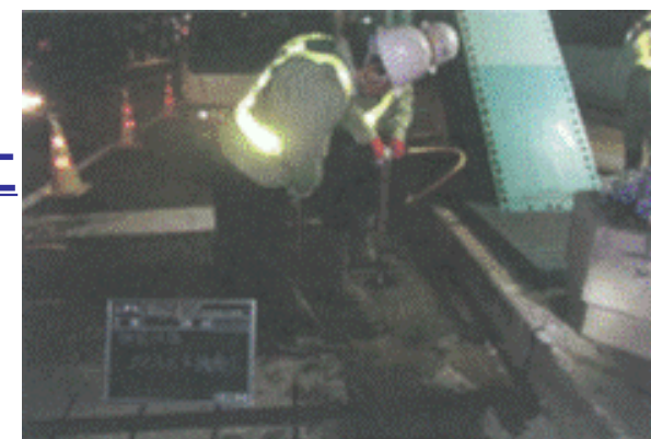
試掘による舗装の健全度調査
