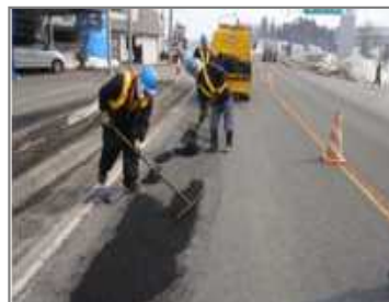
舗装版舗設作業
